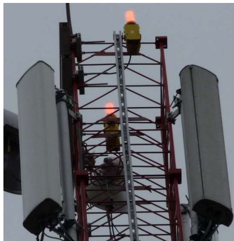
Obrázek 12 - Dvojice světelných překážek umístěných na řešeném stožáru [27]
