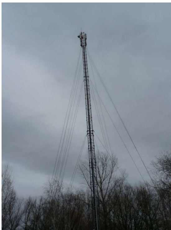
Obrázek 1 - Celkový pohled na stožár
