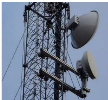
Obrázek 16 - Ukázka mikrovlnných antén umístěných na obdobném stožáru [27]
