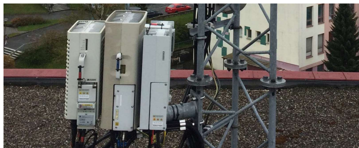
Obrázek 18 - Ukázka umístění RRH modulů na jiném stožáru [27]
