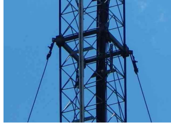
Obrázek 13 - Systém ochrany proti pádu [27]
