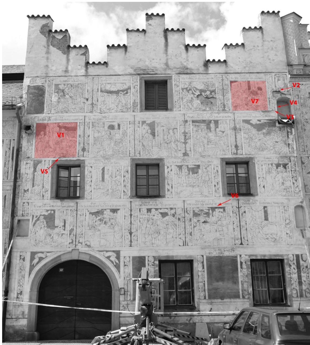
Obr. 56 Lokalizace odběru vzorků na fasádě.
