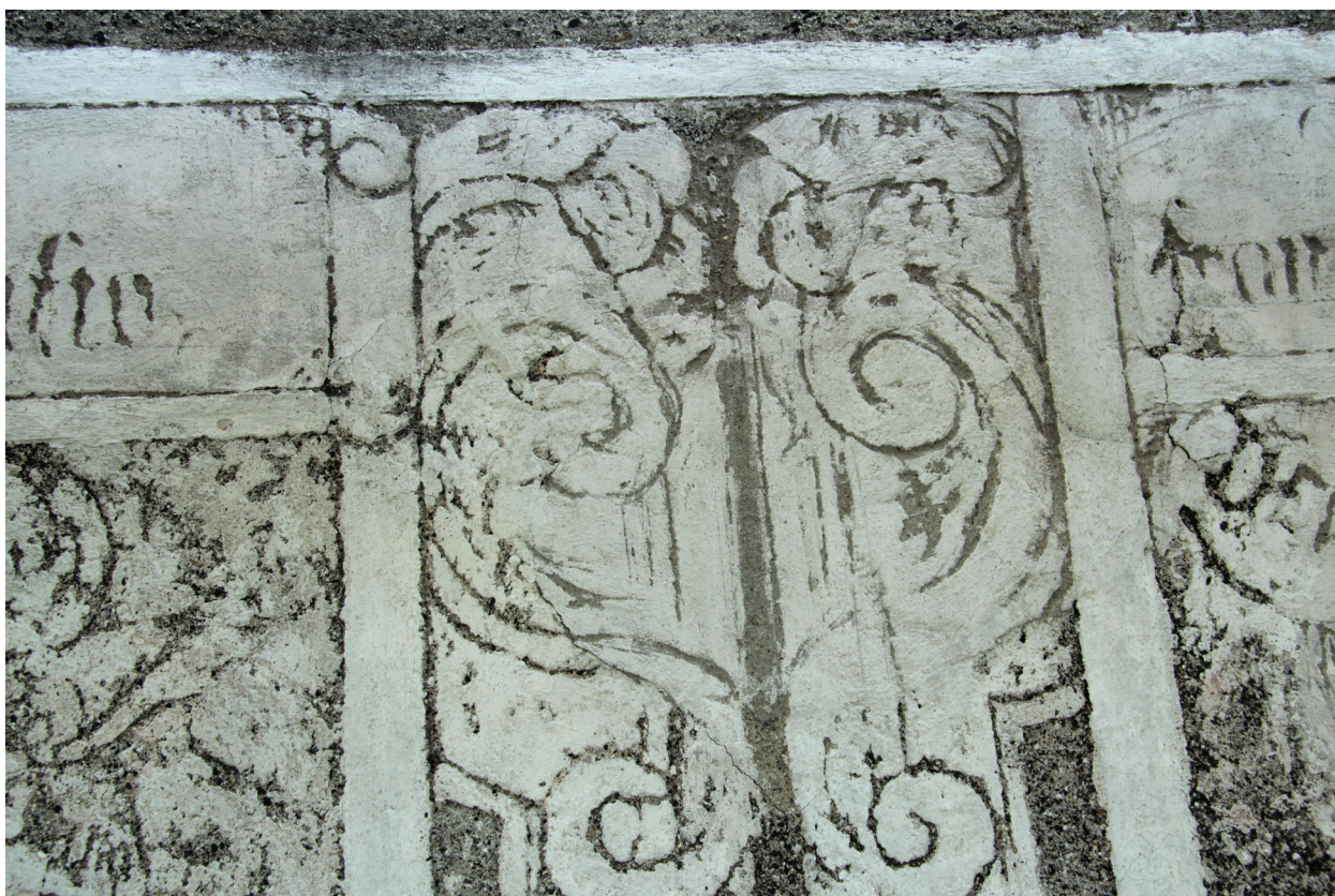
Obr. 53: Detail dekorového pásky s označením D2 před započítím restaurátorského zásahu. Na snímku je viditelný druhotný doplněk lišící se od originálu použitým materiálem, barvou i strukturou. Druhotně provedené intonaco bianco se vyznačuje hutnou barevnou vrstvou neprojevující snahu o napodobení prokletování a často místy zaslepuje samotnou sgrafitovou kresbu.
