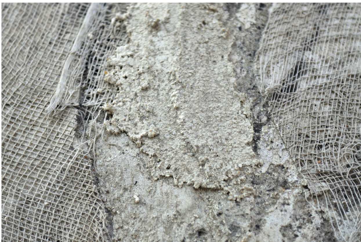
Obr. 73: V místech kde se nacházely trhliny bylo provedeno obětní přetmelení jako ochrana před nečistotami, sněhem a vodou, které by mohly způsobit poškození. Toto přetmelení bylo na počátku další etapy odstraněno pomocí kladívka a skalpelů.s
