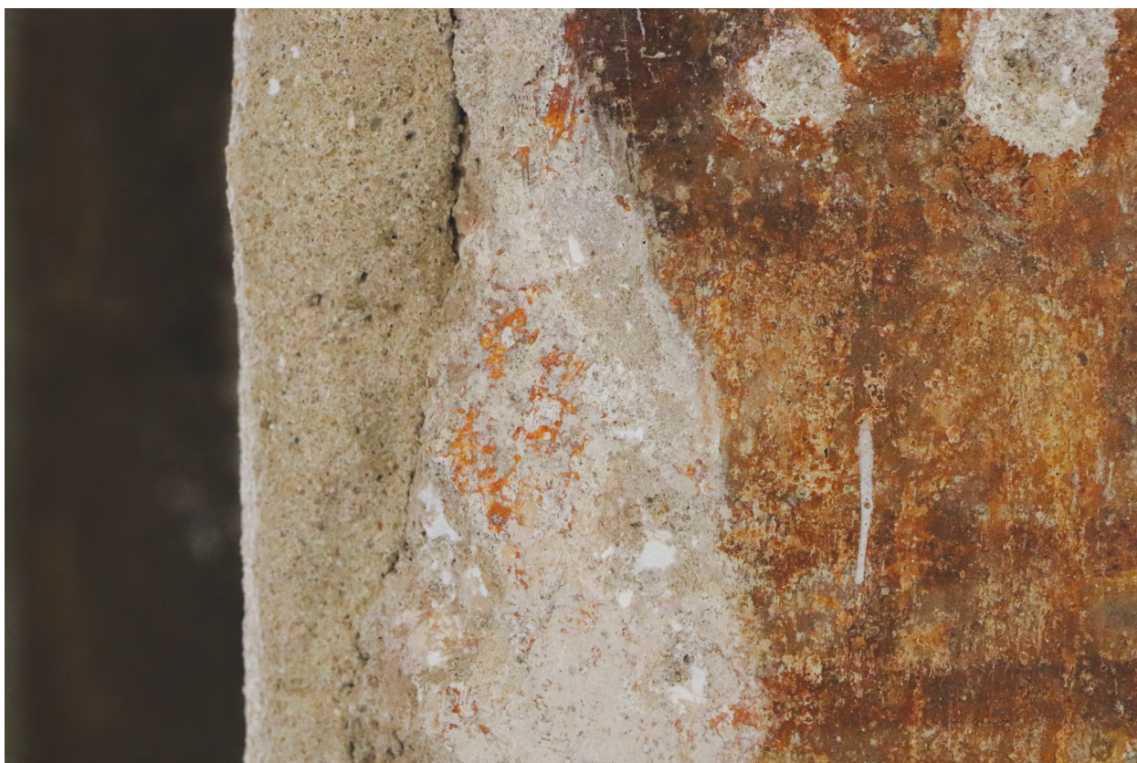
Obr. 37: Detail části restaurovaného úseku po odstranění druhotných tmelů ve střední části restaurovaného úseku, odstraněný tmel z rozhraní dvou omítkových vrstev (dolní pravá polovina fotografie).
