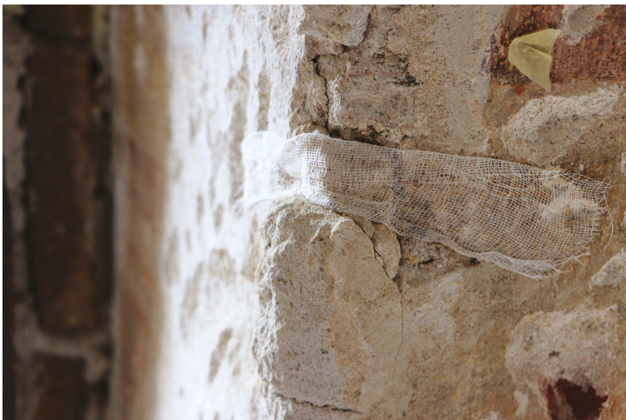
Obr. 35: Průběh odstraňování druhotných tmelů v rozptýleném denním světle. Detail ochranného přelepu (japonský papír) v horní polovině restaurovaného úseku.
