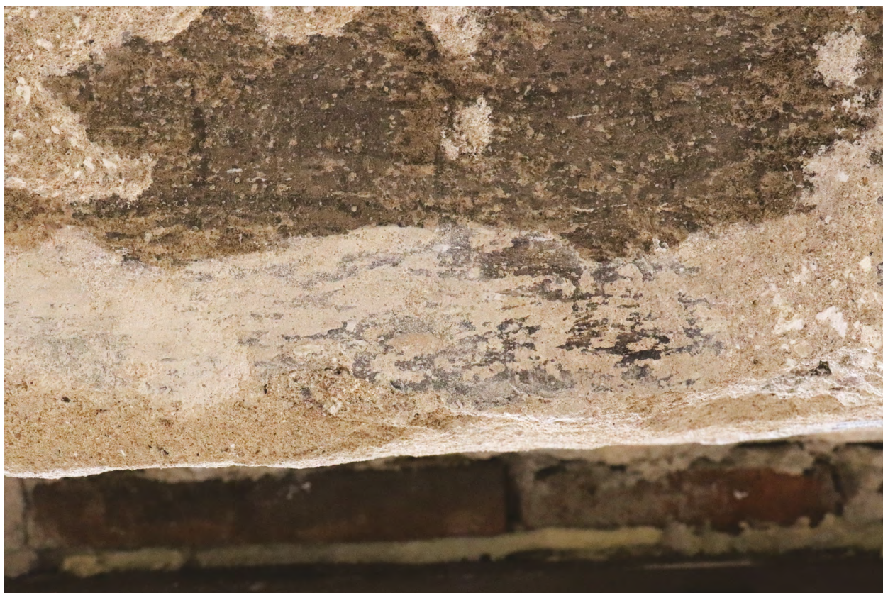
Obr. 45: Detail originální barevné vrstvy po odstranění velkoplošného druhotného tme- lu. Levá strana restaurovaného úseku.
