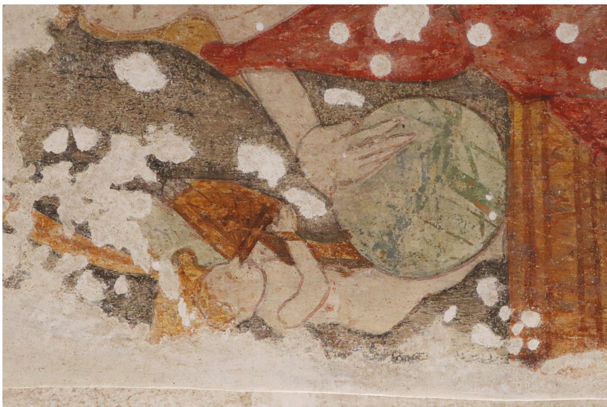
Obr. 71: Sekvence, stav díla po provedené retuši v rozpřáleném denním světle. Detail andělčička, horní část výjevu.
