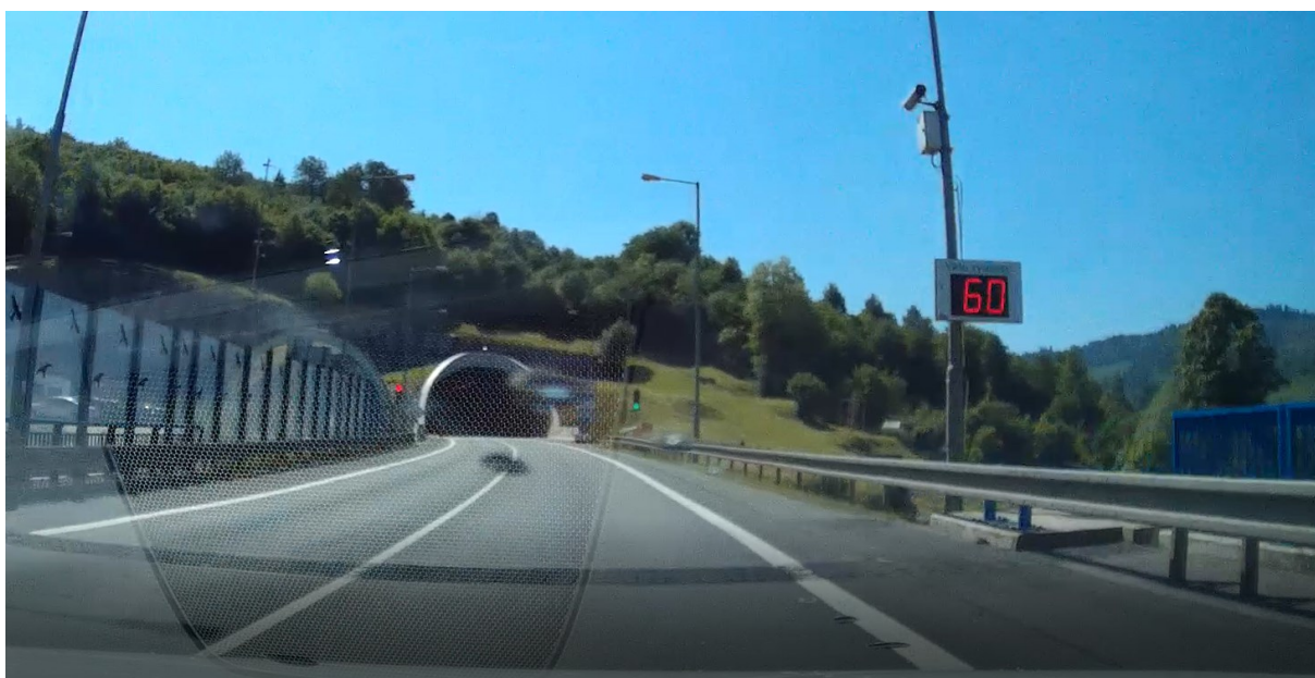
Obrázek 61 Vjazd do tunela Horelica (autor)
