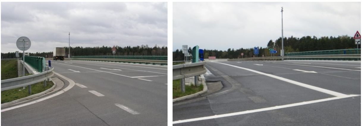
Obrázek 43 Výhľad vodiča na križovatke pred a po úprave vodorovného značenia (Observař bezpečnosti silničního provozu, 2015b)
