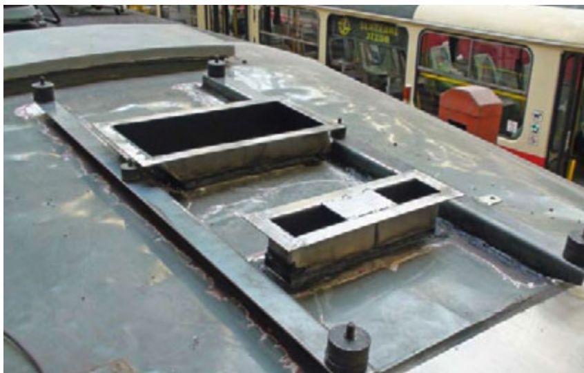
Obrázek 16 Úprava střechy pro montáž klimatizační jednotky (Kaprálek, 2014)
