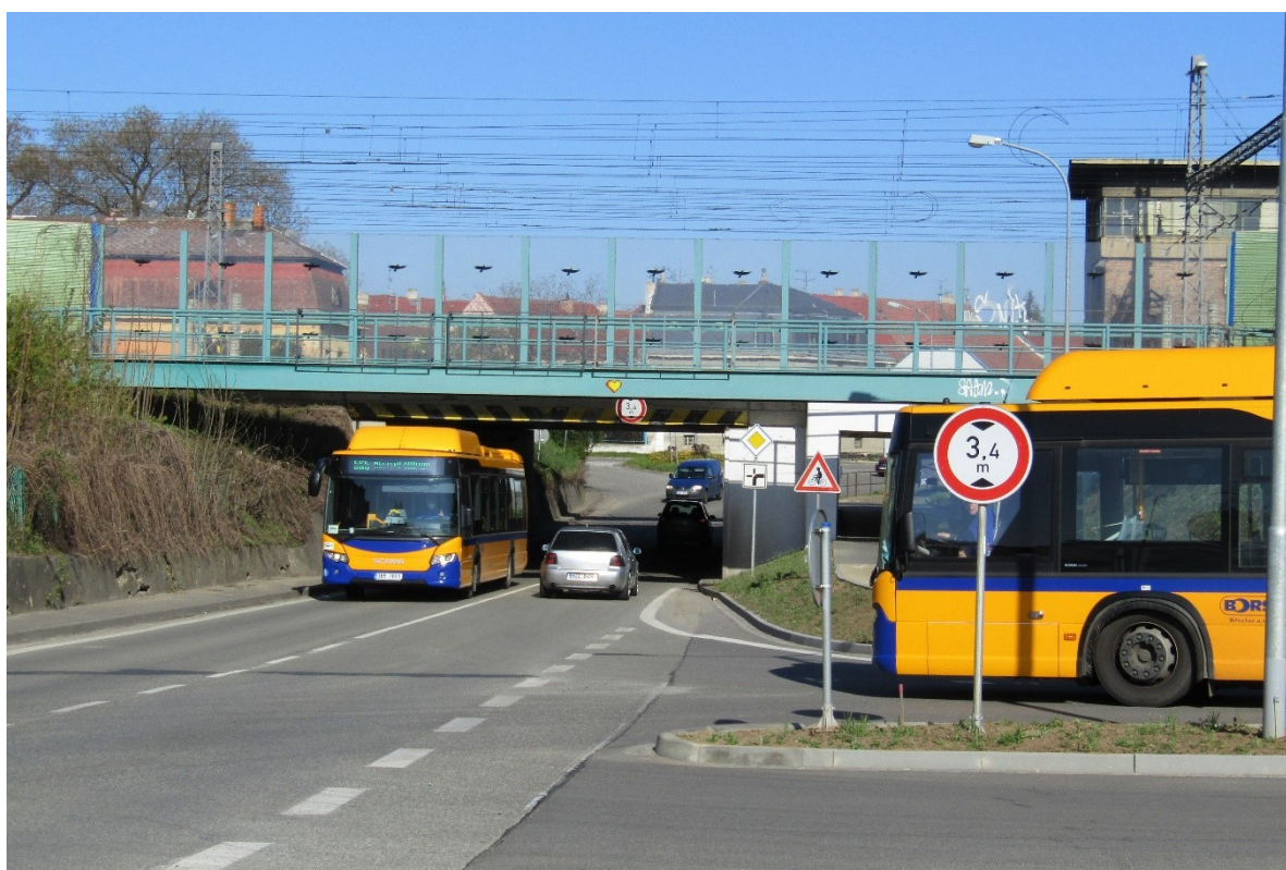
Obrázek 5 Problematický podjezd pod železnicí na ulici Bratislavská (autor, 2021)
