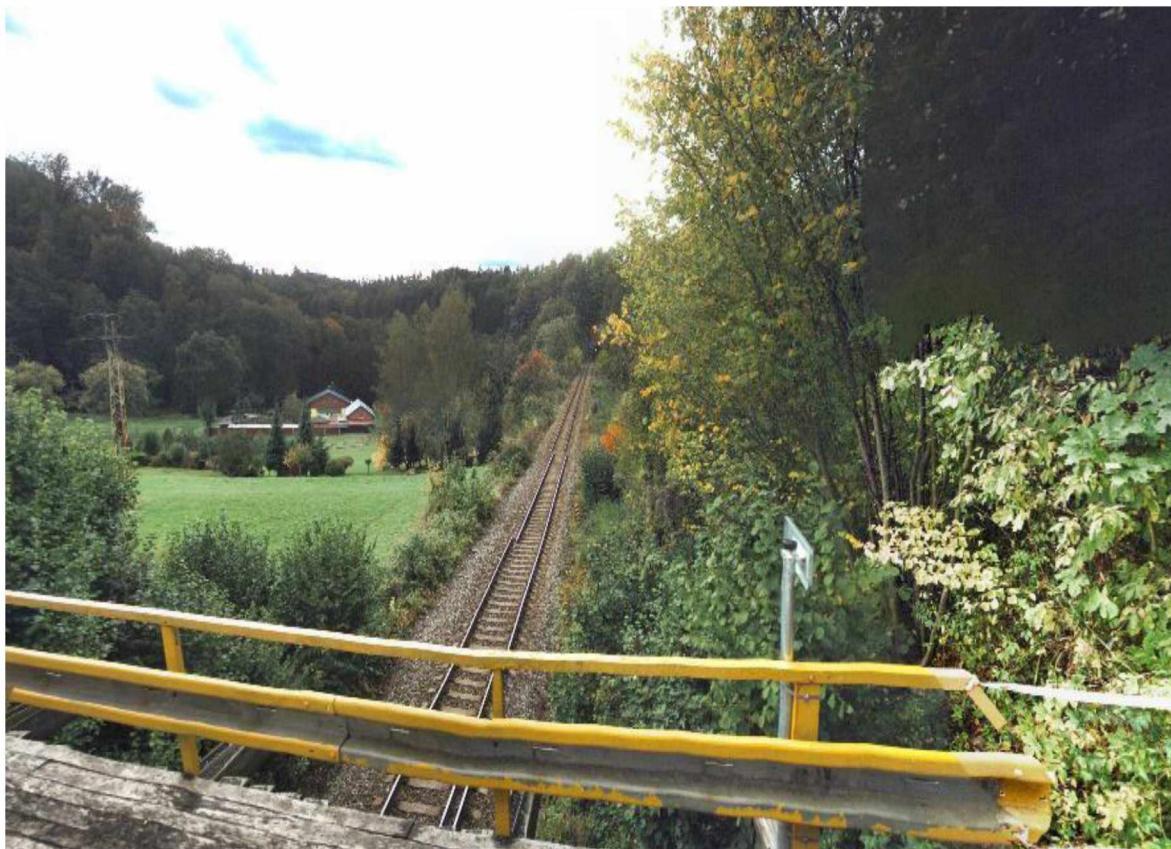
Obrázek 15 pohled na trať 030, začátek úseku A
