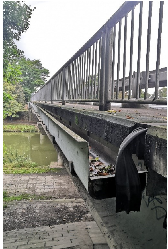
Obrázek 13 - Mostní závěr v římse u O1L
