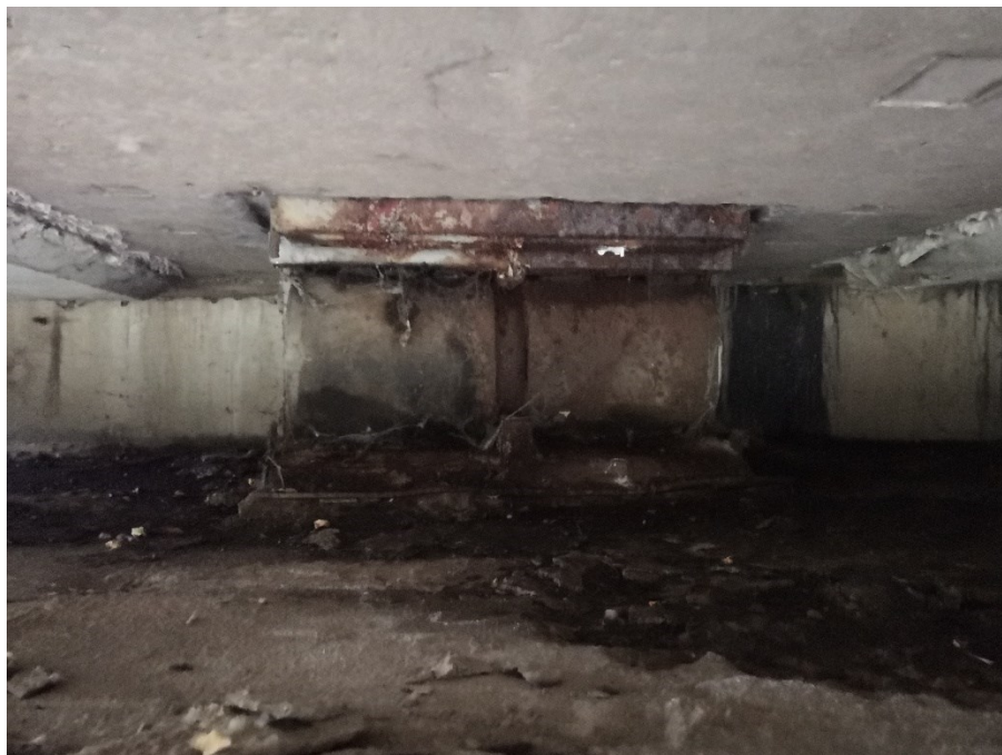
Obrázek 25 - Detail korodujícího ložiska
