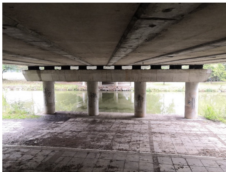
Obrázek 5 - Pohled z opěry O1 na podpěru P2, první pole
