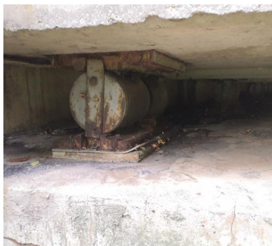
Obrázek 7 - Detail válcového ložiska
