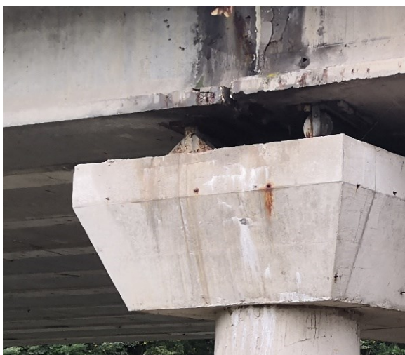
Obrázek 6 - Pohled na P3 – vlevo pevné ložisko
