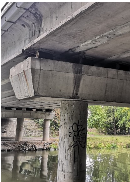
Obrázek 16 – Svislé výluhy na stativu u P2L
