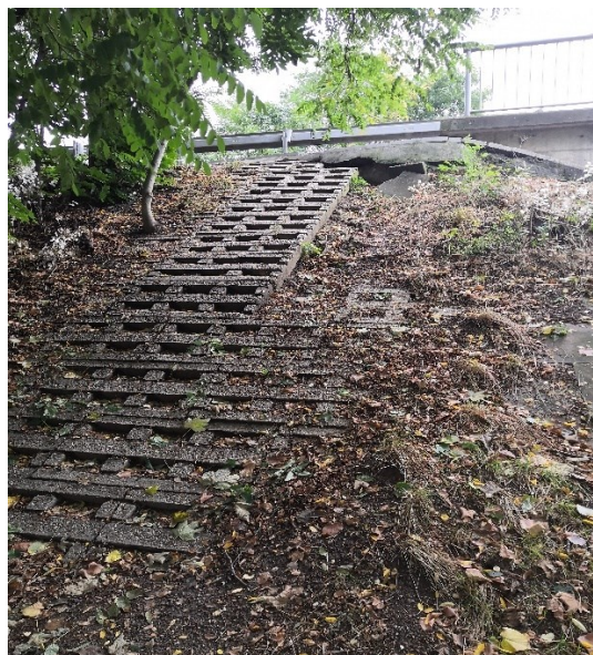
Obrázek 29 - Pohled na revizní schodiště u O4L
