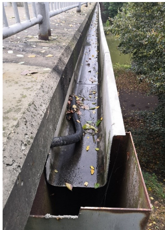
Obrázek 11 - Napojení podélného na svislý svod
