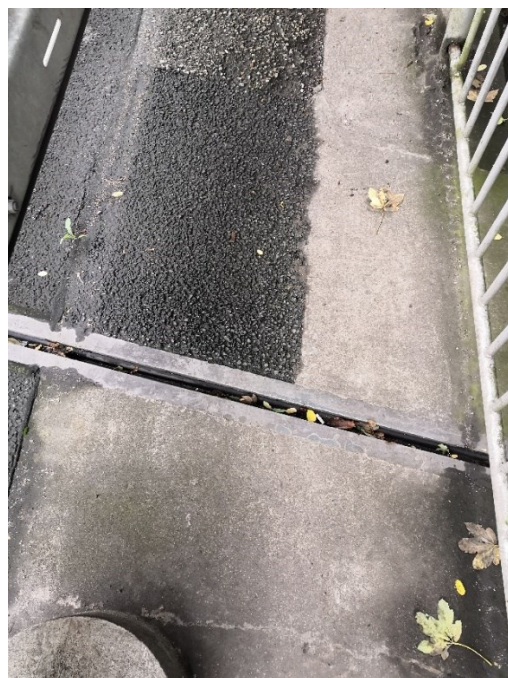
Obrázek 9 - Pohled na mostní závěr v římsce
