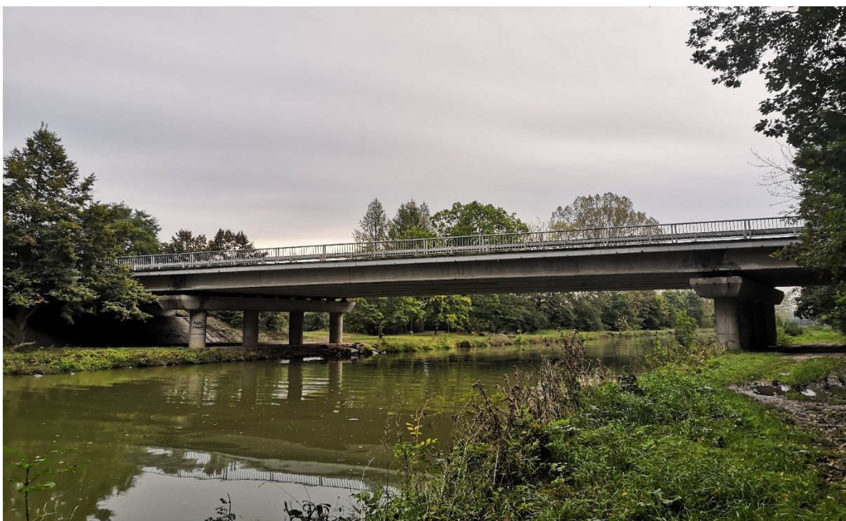
Obrázek 1 – Pohled proti proudu řeky Cidliny na most ev.č. 32-001
