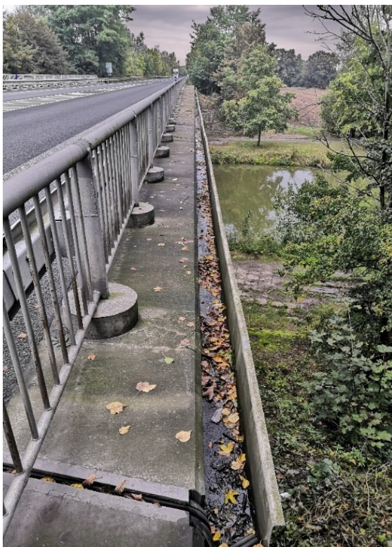
Obrázek 10 - Pohled na podélný svod, pravá římsa
