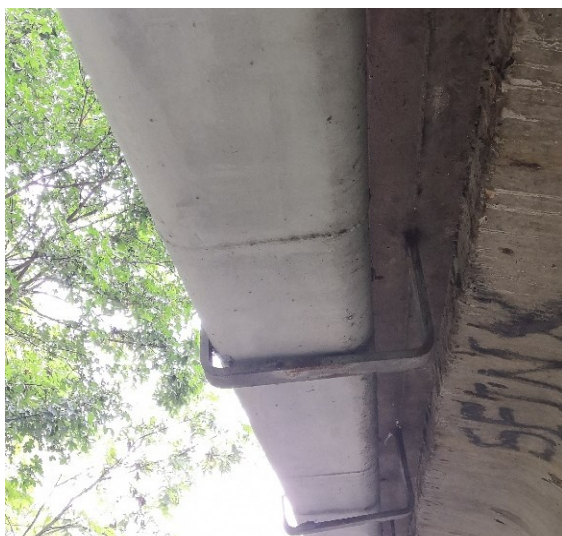
Obrázek 26 - Uchycující přípravky odvodňovačů
