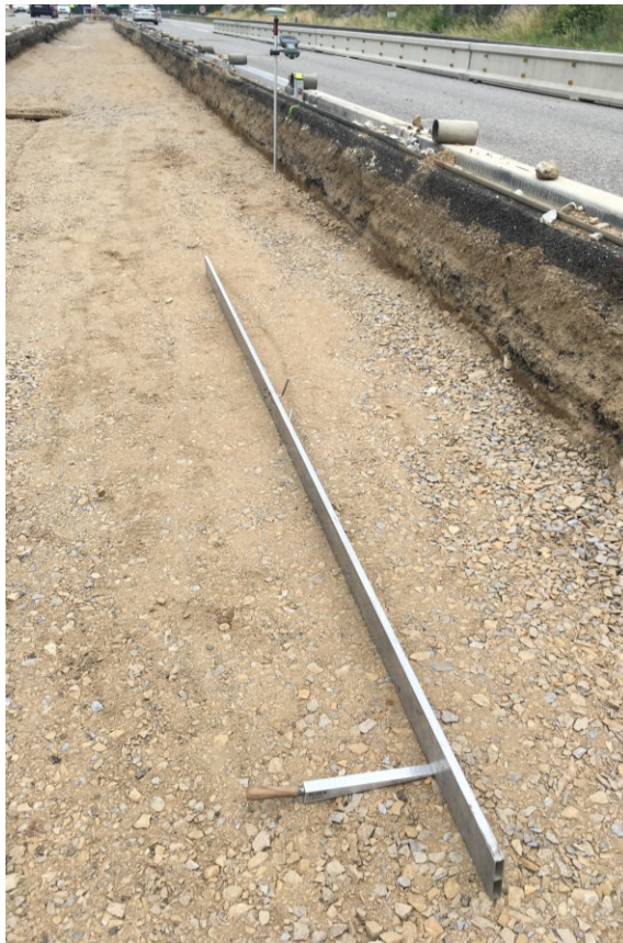
Obrázek 6: Měření podélných nerovností latí [vlastní fotografie]
