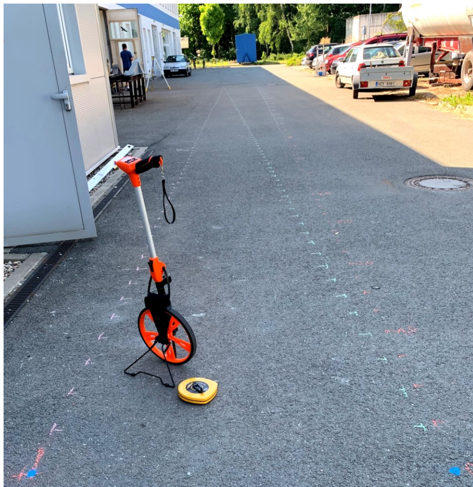
Obrázek 51: Příprava zkušební úseku č. 1 [vlastní fotografie]
