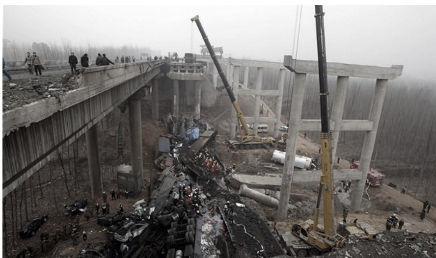
Obrázek 9 Následky výbuchu nákladního automobilu s pyrotechnikou na dálničním mostě [45]
