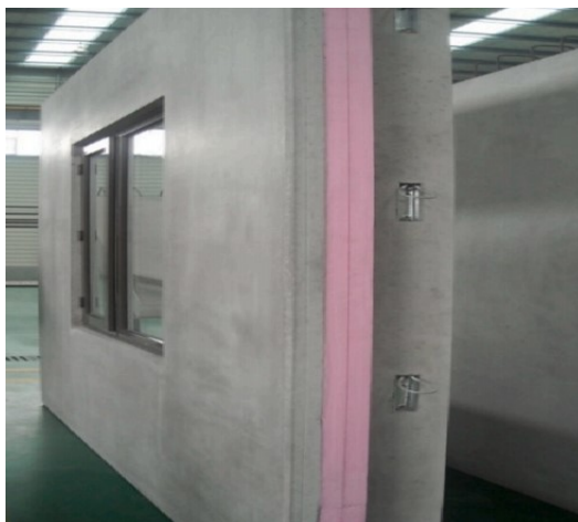
Obrázek 16 Prefabrikovaný sendvičový panel [49]
