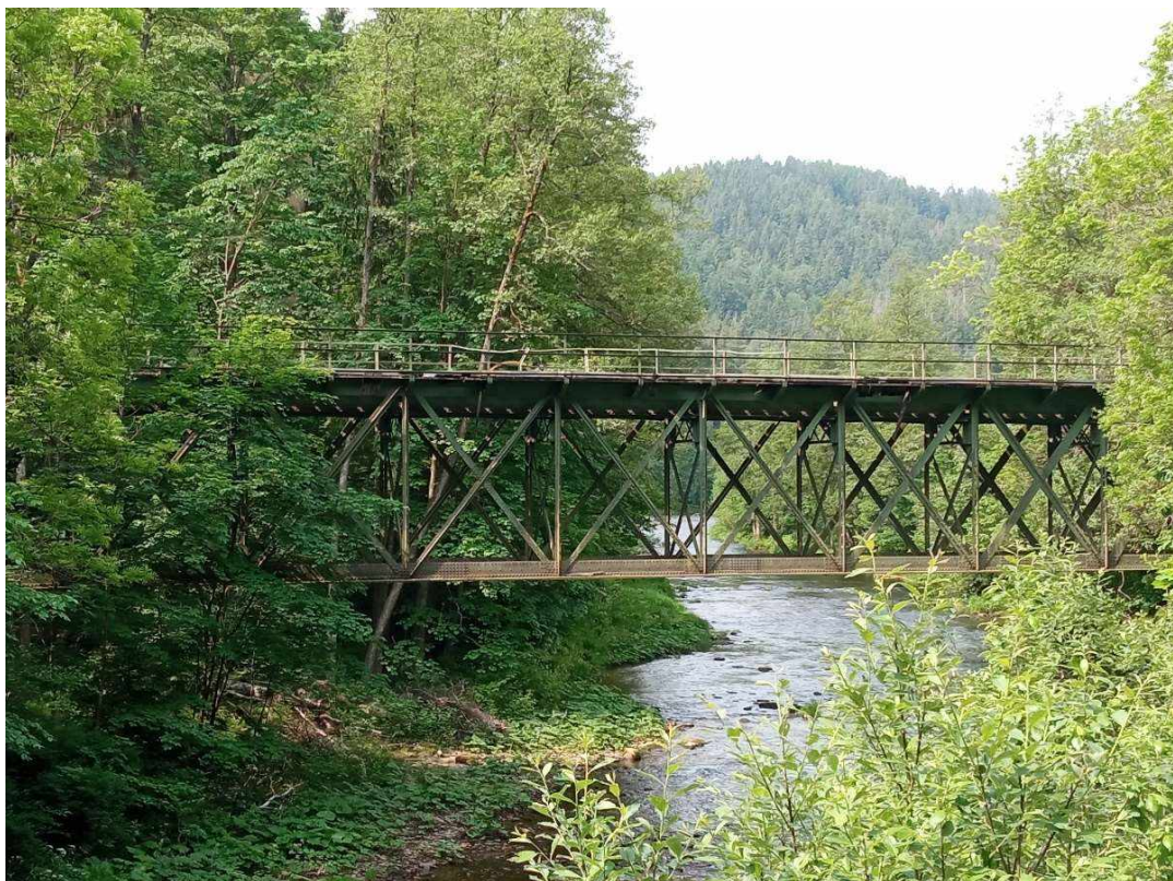
Obr. 4 – Boční pohled na mostní objekt
