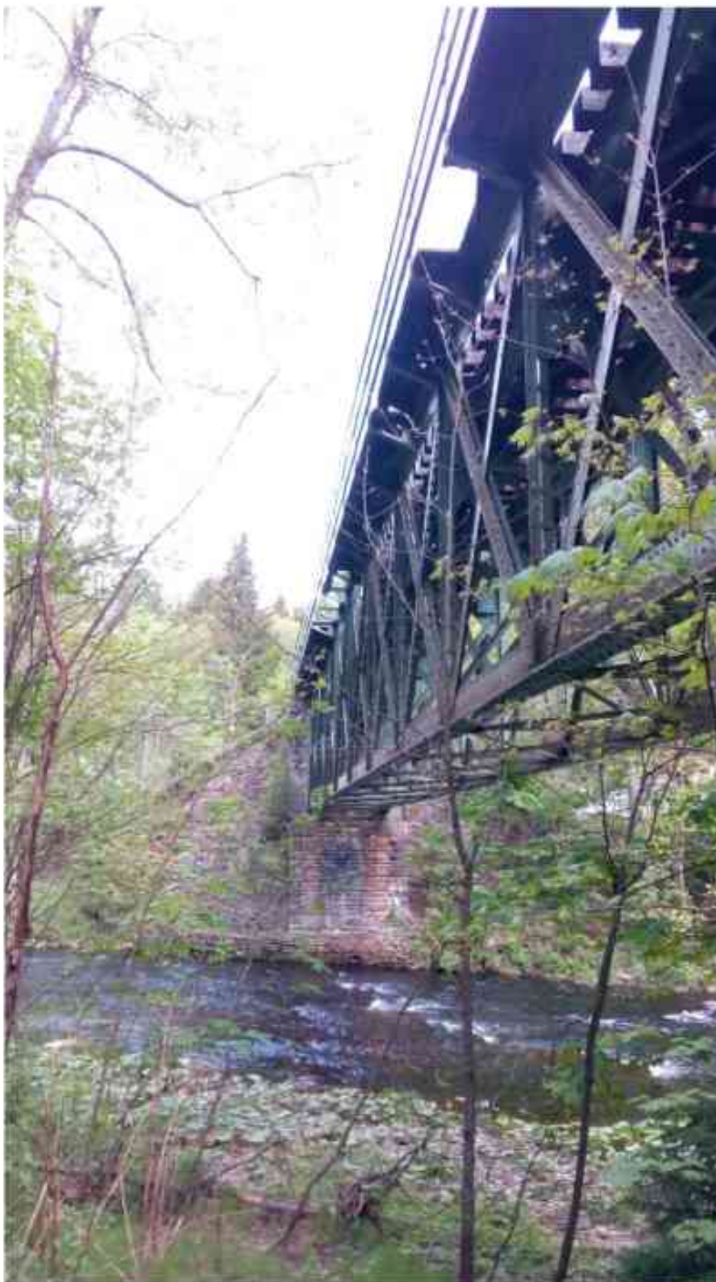
Obr. 14 – Pohled na koryto řeky pod mostním objektem
