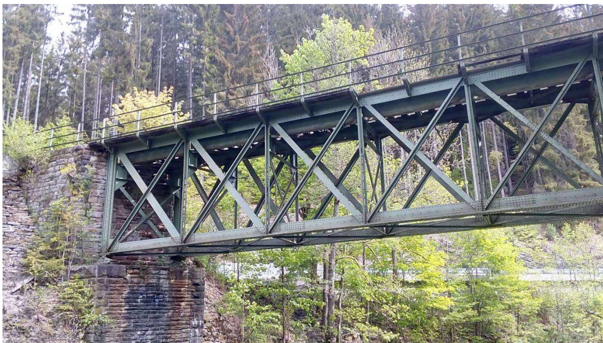
Obr. 12 – Opěra se závěrnou zdí na jablonecké straně s čtyřválcovými pohyblivými ložisky
