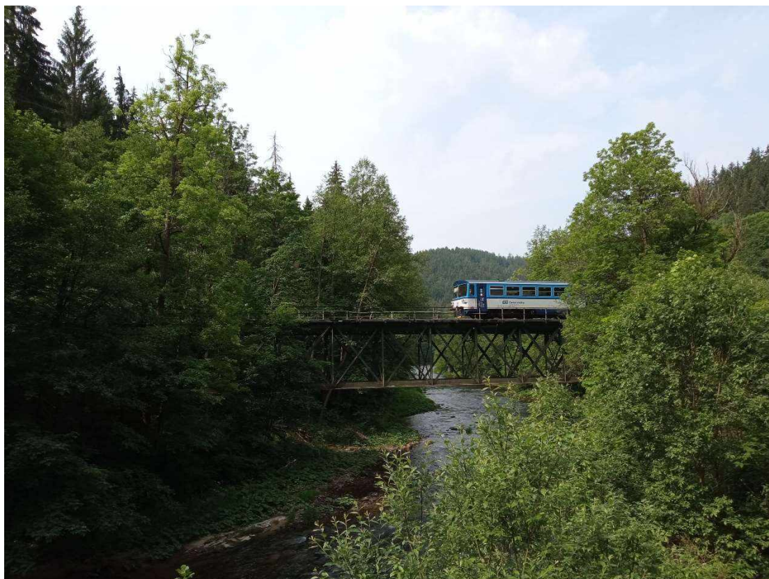
Obr. 9 – Pohled na most přes Jizeru „zatížený“ dopravou (Os 15505 – Jablonec n. Jizerou – Martinice v Krkonoších)
