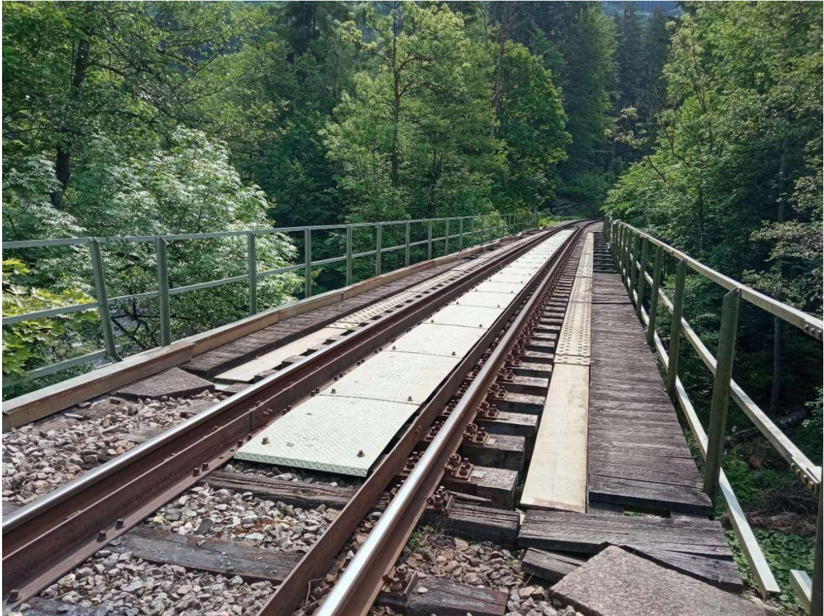
Obr. 3 – Pohled na mostní svršek směrem na Jilemnici
