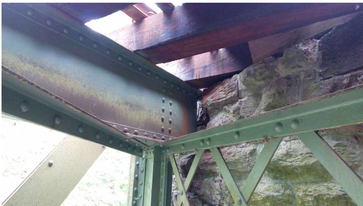
Obr. 5 – Podélník opřený do závěrné zdi
