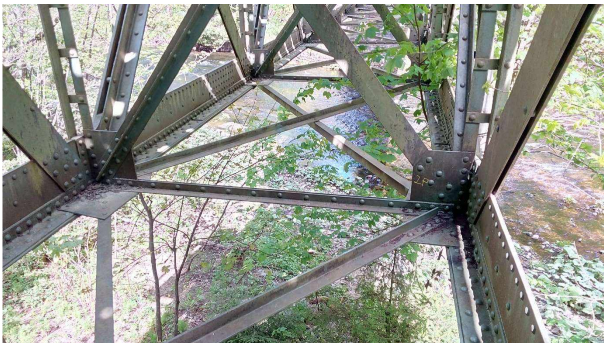
Obr. 7 – Detail napojení zavětrování hlavních nosníků
