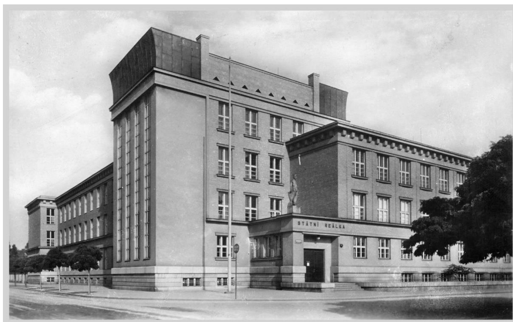
Obr. č. 8: Nová budova Státní reálné školy. 282
