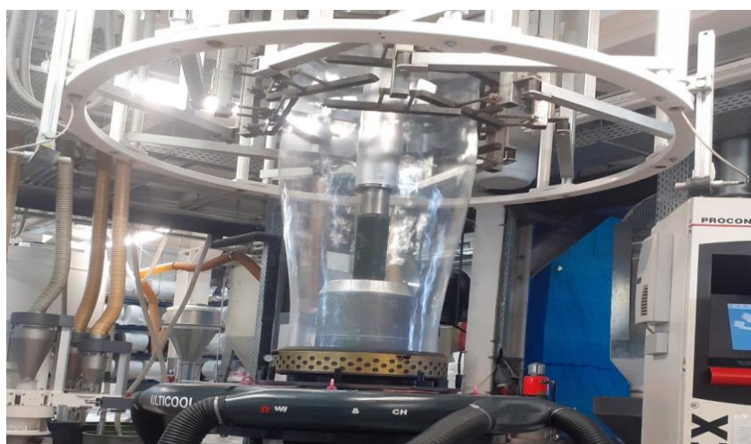
Obrázek 5: Vyfukovací hlava a "rukáv" folie – vyfukovací zařízení ve firmě M.G. Italy
