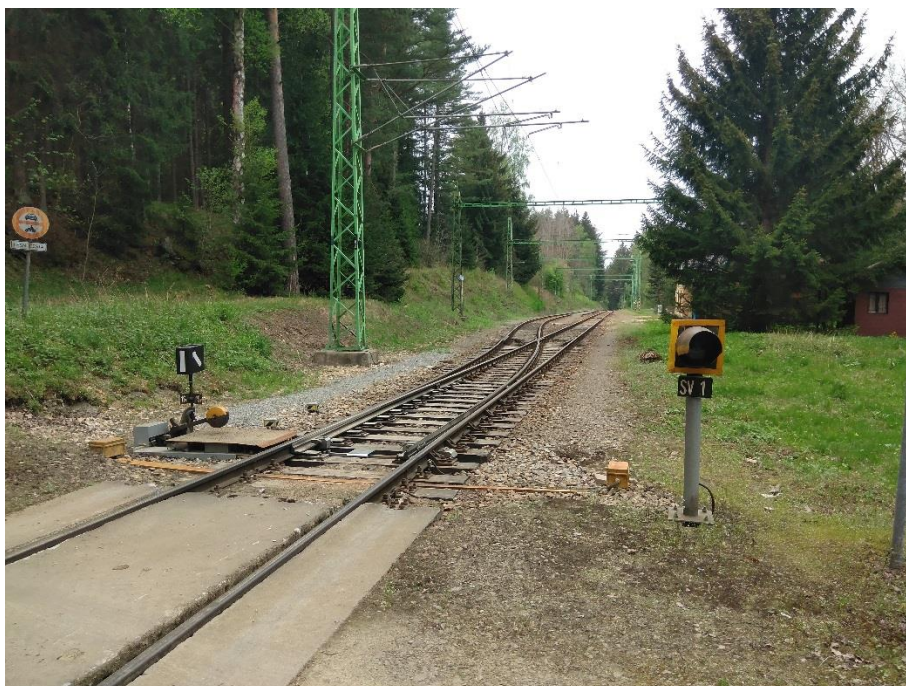
Obrázek D 1 – Výměna se samovratným přestavníkem a její návěstidlo (dopravna D3 Rožmberk nad Vltavou)
