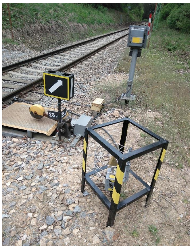
Obrázek D 1 – Výměna se samovratným přestavníkem a její návěstidlo (dopravna D3 Rožmberk nad Vltavou)
