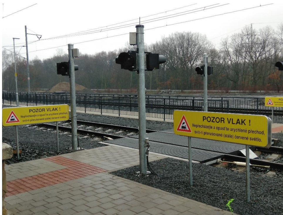
Obrázek F 1 - Centrální přechod bez výstražného zařízení (ŽST Slatiňany)
