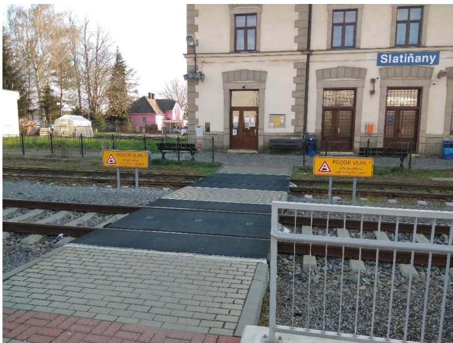
Obrázek F 1 - Centrální přechod bez výstražného zařízení (ŽST Slatiňany)
