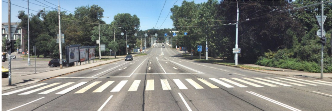
Obrázek 21: Nedělený přechod pro chodce řízený SSZ
