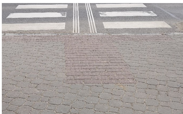
Obrázek 28: Nedodržení návaznosti na vodící linii
