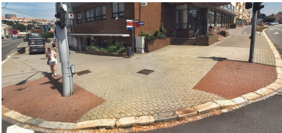
Obrázek 26: Nedodržení rozměrů hmatových prvků
