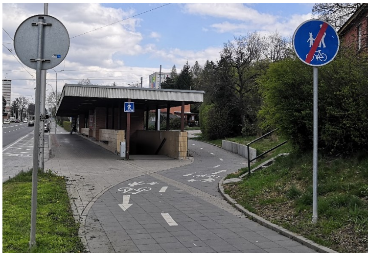
Obrázek 54: Rozpor vodorovného a svislého dopravního značení
