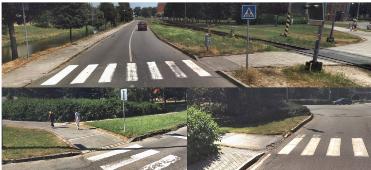
Obrázek 25: Chybějící hmatové prvky
