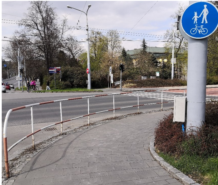
Obrázek 55: Chybějící vodorovné značení
