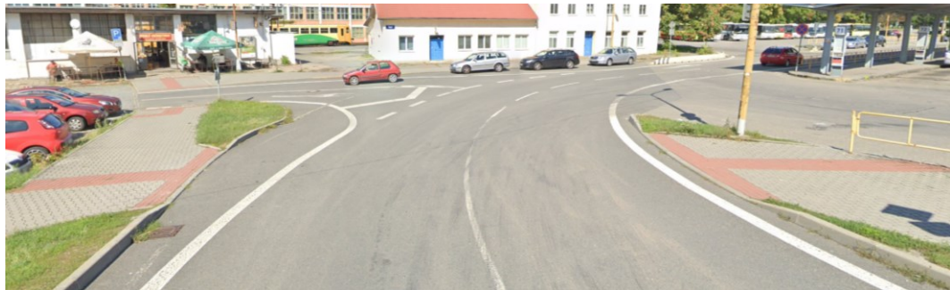
Obrázek 30: Nedodržení odsazení signálního pásu
