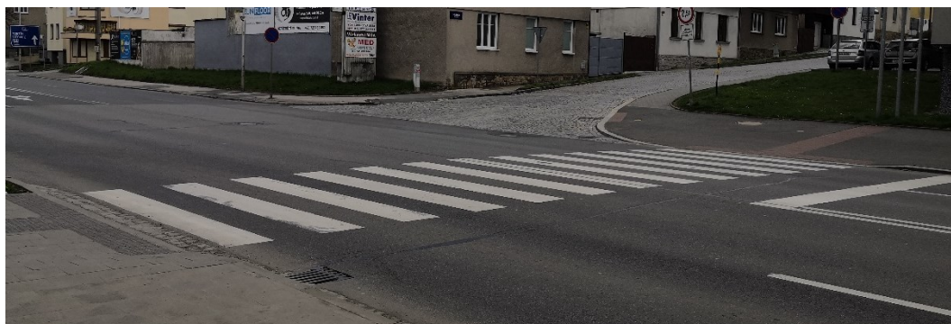
Obrázek 23: Nedělený přechod pro chodce neřízený SSZ
