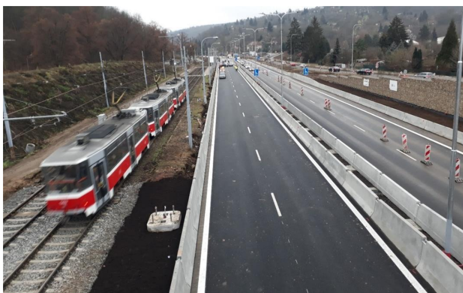
Obrázek 9: Souprava 3x T6A5 jedoucí podél nového úseku VMO
