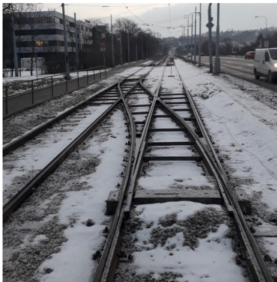
Obrázek 17: Kolejová spojka využívaná linkou 11
