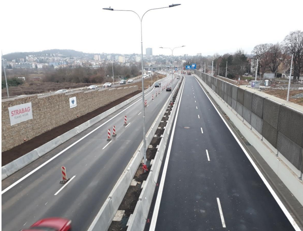
Obrázek 8: Nový úsek PK před zprovozněním
