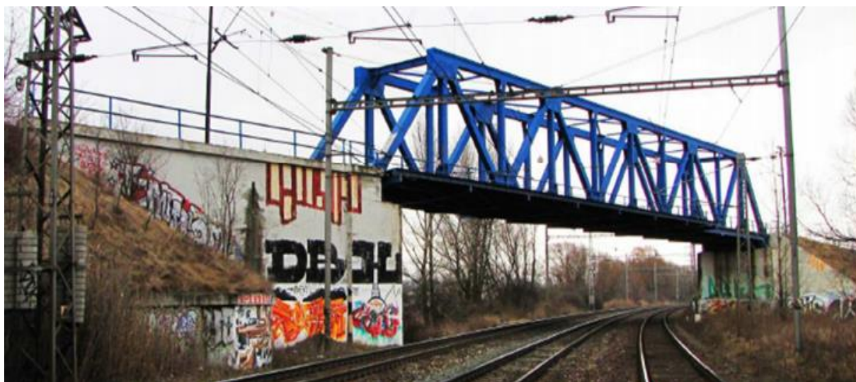
Obrázek 4 - Traťová kolej 2S mimoúrovňově křížující traťové koleje 1,2 a 1S. Zdroj: www.spravazeleznic.cz
