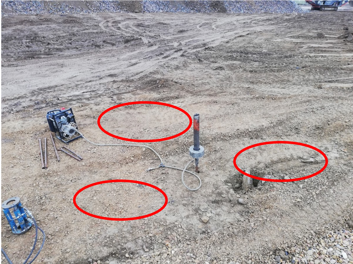
Obrázek 31. Fotografie z provádění dynamické penetrační zkoušky
