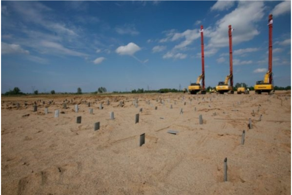
Obrázek 6. Vertikální drény [Menard s.r.o.]
