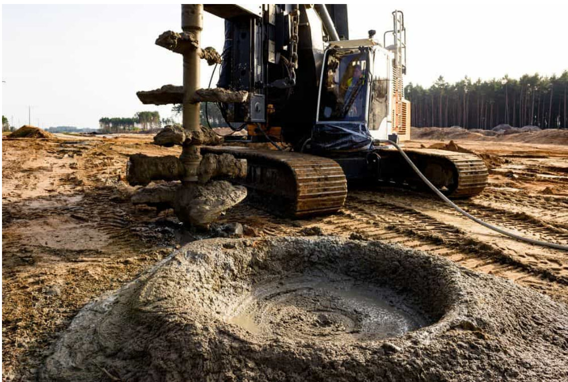
Obrázek 4. Hloubkové míchání zemin [Menard s.r.o.]
