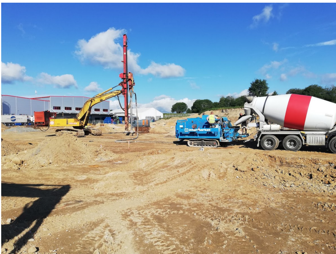
Obrázek 2. Realizace betonových pilířů
