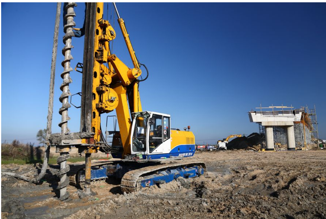
Obrázek 3. Realizace betonových pilířů CFA [Menard s.r.o.]
