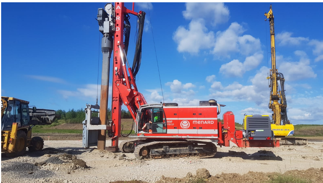
Obrázek 1. Realizace štěrkových pilířů
