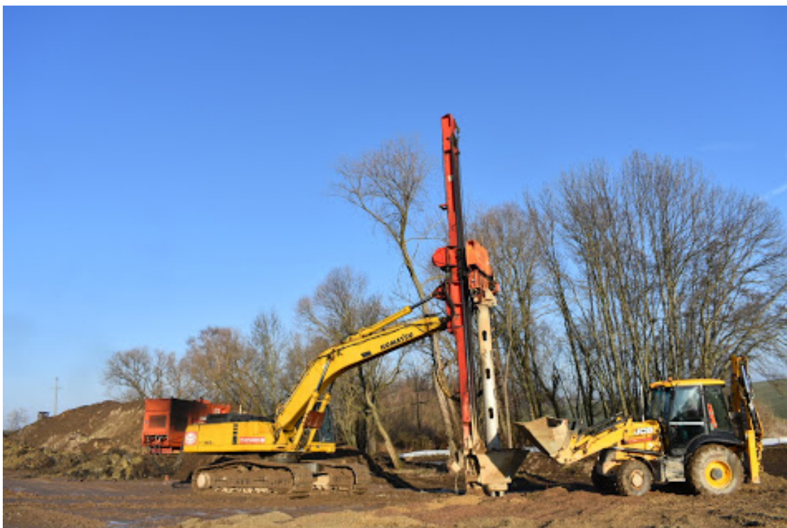
Obrázek 11. Štěrkové pilíře na D35
