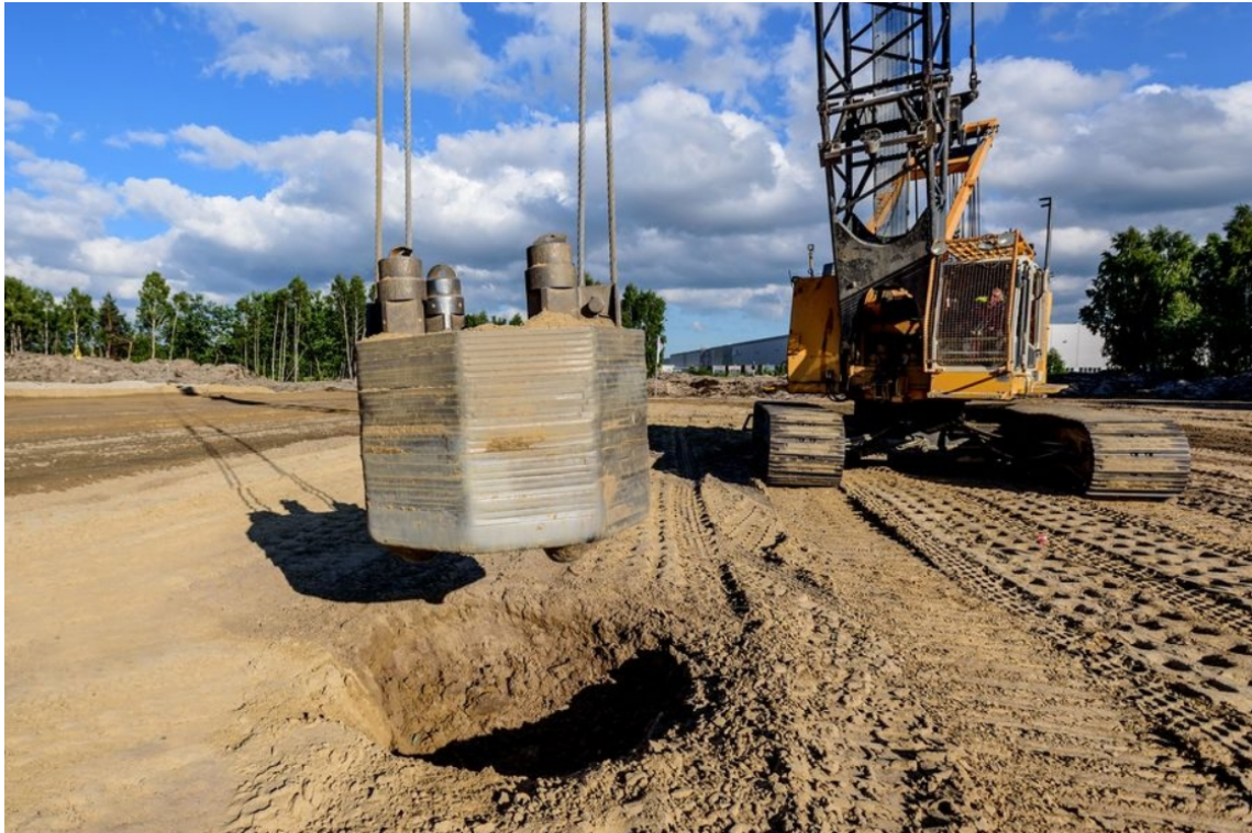
Obrázek 5. Dynamická konsolidace [Menard s.r.o.]
