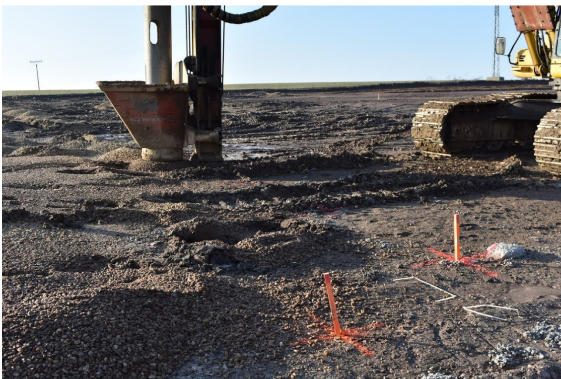
Obrázek 10. Štěrkové pilíře na D35
