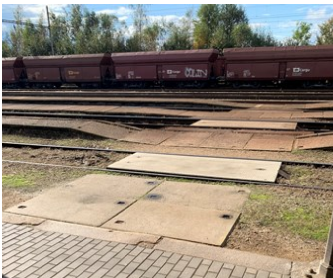
Obrázek 7 – Přechod v km 242,914
