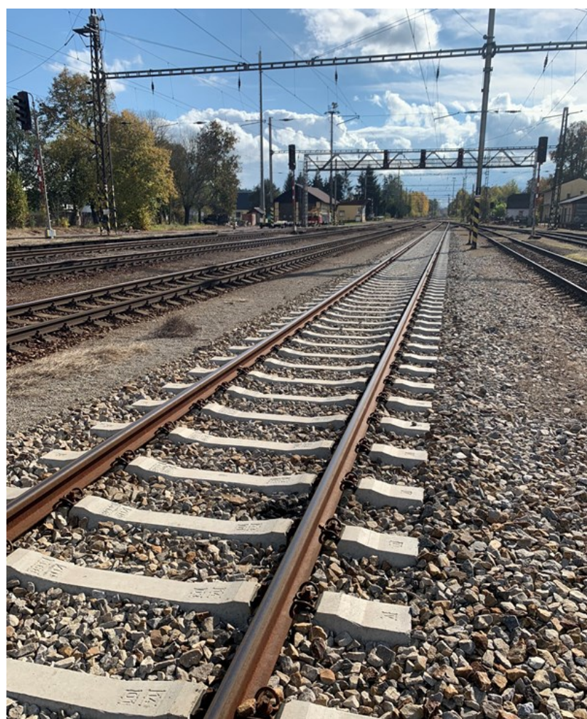
Obrázek 25 – Částečně zrekonstruovaná kolej č. 3
