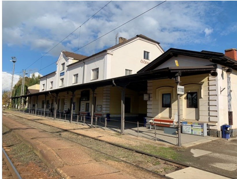
Obrázek 16 – Výpravní budova ŽST Čičenice
