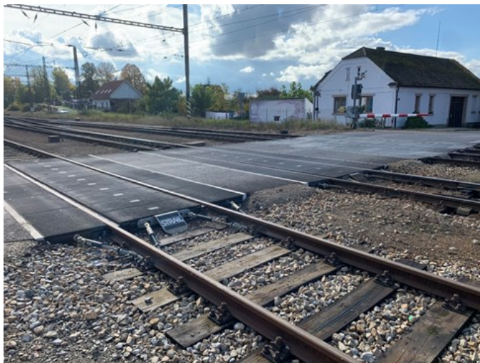
Obrázek 6 – Železniční přejezd č. P1144
