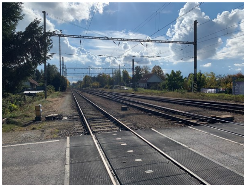
Obrázek 22 – Železniční přejezd P1144, pohled na budějovické zhlaví
