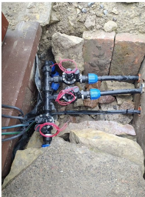
Obr. 4.6 – Zapojení a umístění ventilů
