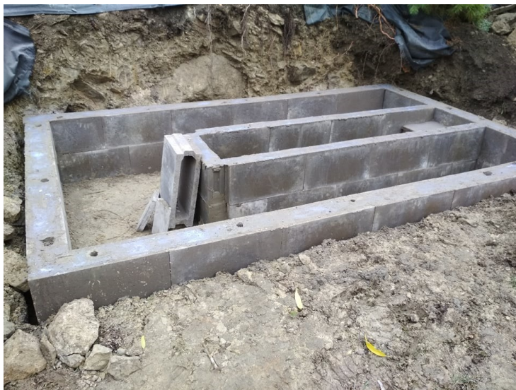
Obr. 4.2 – Základy pro skleník
