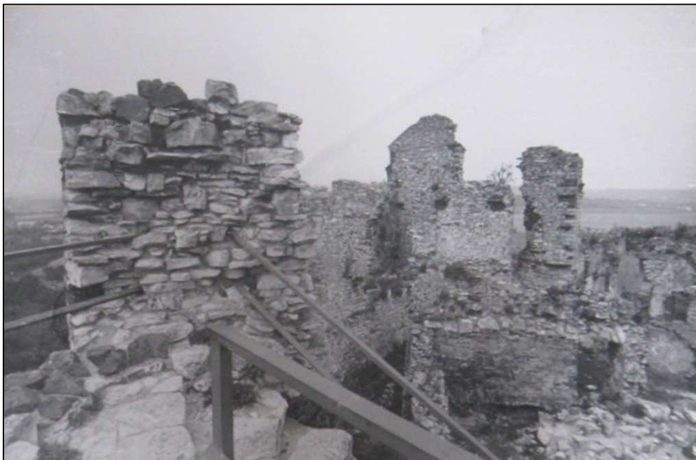
Foto 18. Stav „starého hradu“ v době statického průzkumu zříceniny v roce 1974, pohled z vyhlídky na „opěráku č. 1“. Vlevo torzo meziokenního pilíře „vnější obvodové zdi“, vpravo dole „zdivo obytné věže“, nahoře uprostřed torzo „spojovacího křídla“, vpravo vzadu „nový palác“. Převzato z: NPÚ, archiv Územního odborného pracoviště v Pardubicích. sign. K 123/2. Hrad Košumberk. Statický průzkum. Fotodokumentace. foto 1. Státní ústav pro rekonstrukci památkových měst a objektů v Praze. říjen 1974.
