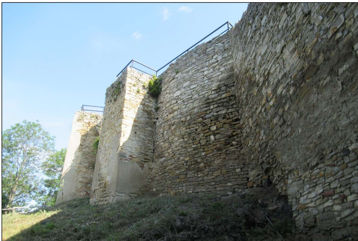
Foto 28. Západní úsek „vnější obvodové zdi“ s „opěráky č. 1“ (vlevo) a „č. 2“ (uprostřed), vpravo západní průčelí vstupní věže. Současný stav, pohled od jihozápadu. Foto autor, 15. 7. 2020.
