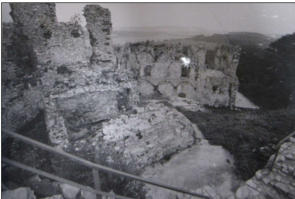
Foto 19. Stav „starého hradu“ v době statického průzkumu zříceniny v roce 1974, pohled z vyhlídky na „opěráku č. 1“. Uprostřed dole „zdivo obytné věže“ a prostor „malé světničky“, vzadu torzo „spojovacího křídla“ a „nového paláce“. Převzato z: NPÚ, archiv Územního odborného pracoviště v Pardubicích. sign. K 123/2. Hrad Košumberk. Statický průzkum. Fotodokumentace. foto 2. Státní ústav pro rekonstrukci památkových měst a objektů v Praze. říjen 1974.
