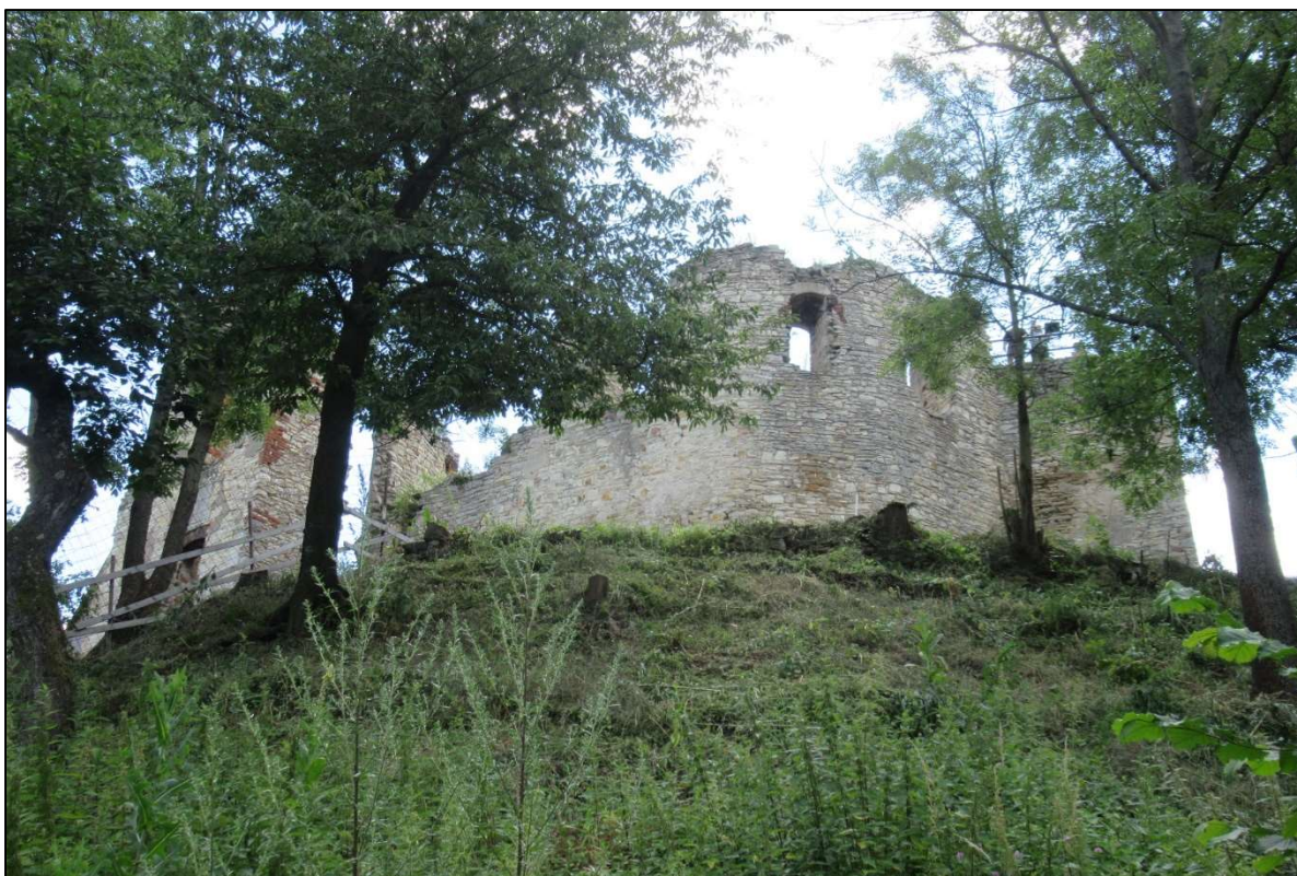
Foto 29. Severní úsek „vnější obvodové zdi“ s meziokenními pilíři, vpravo „opěrák č. 1“, vlevo torzo „spojovacího křídla“. Současný stav, pohled od severozápadu. Foto autor, 15. 7. 2020.
