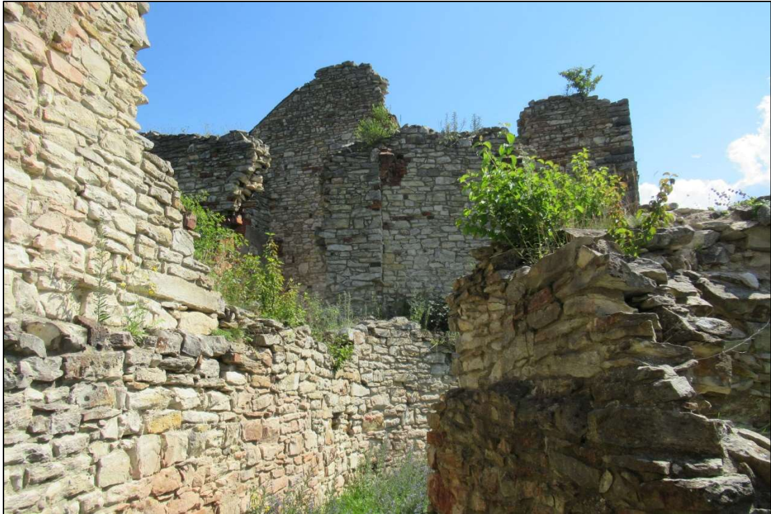
Foto 35. Prostor „ochozu na starém hradě“. Vlevo „vnější obvodová zeď“, vpravo „zdivo obytné věže“, vzadu zříceniny „spojovacího křídla“. Současný stav. Foto autor, 15. 7. 2020.
