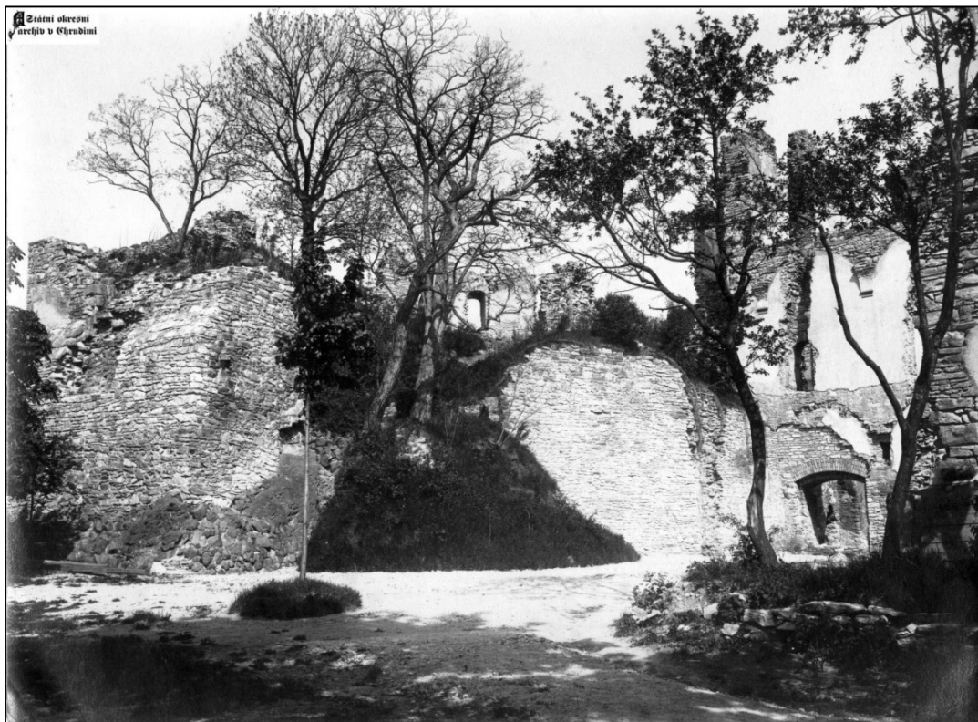
Foto 12. „Starý hrad“ a „spojovací křídlo“ po konzervaci. Pohled z hlavního nádvoří. Uloženo v: SOkA Chrudim. fond č. 1480 Družstvo na záchranu hradu Košumberka. inv. č. 1111, ft. 919/9. po 1922.
