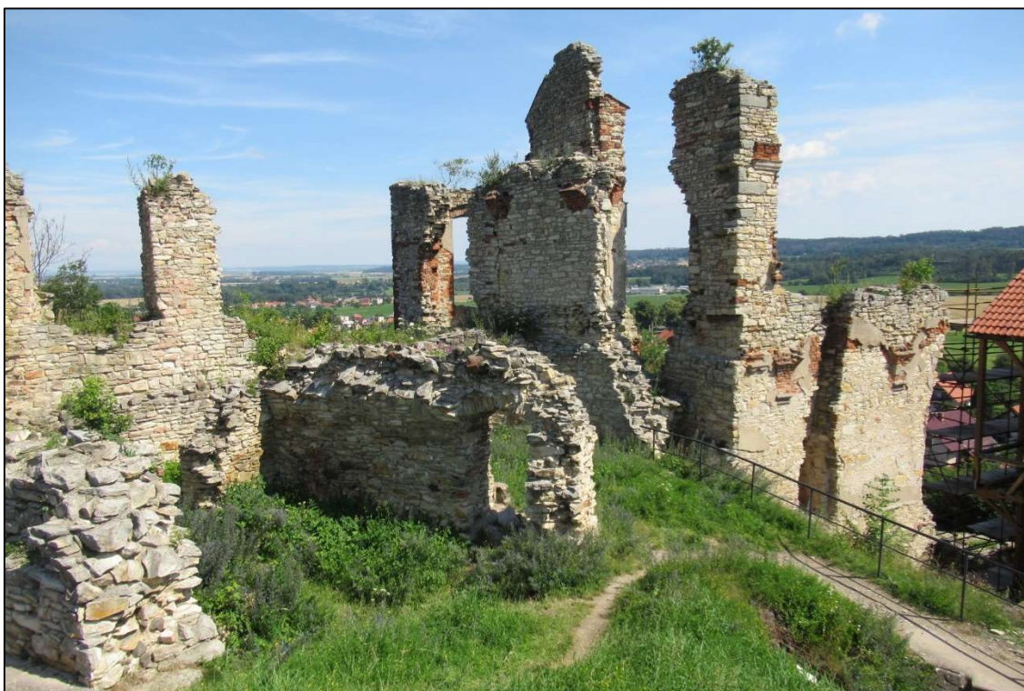
Foto 32. Pohled na areál „starého hradu“ z vyhlídky na „opěráku č. 2“. V popředí „zdivo obytné věže“, za ním severní úsek „vnější obvodové zdi“ s meziokenními pilíři. Vpravo zříceniny „spojovacího křídla nového paláce“. Současný stav. Foto autor, 15. 7. 2020.
