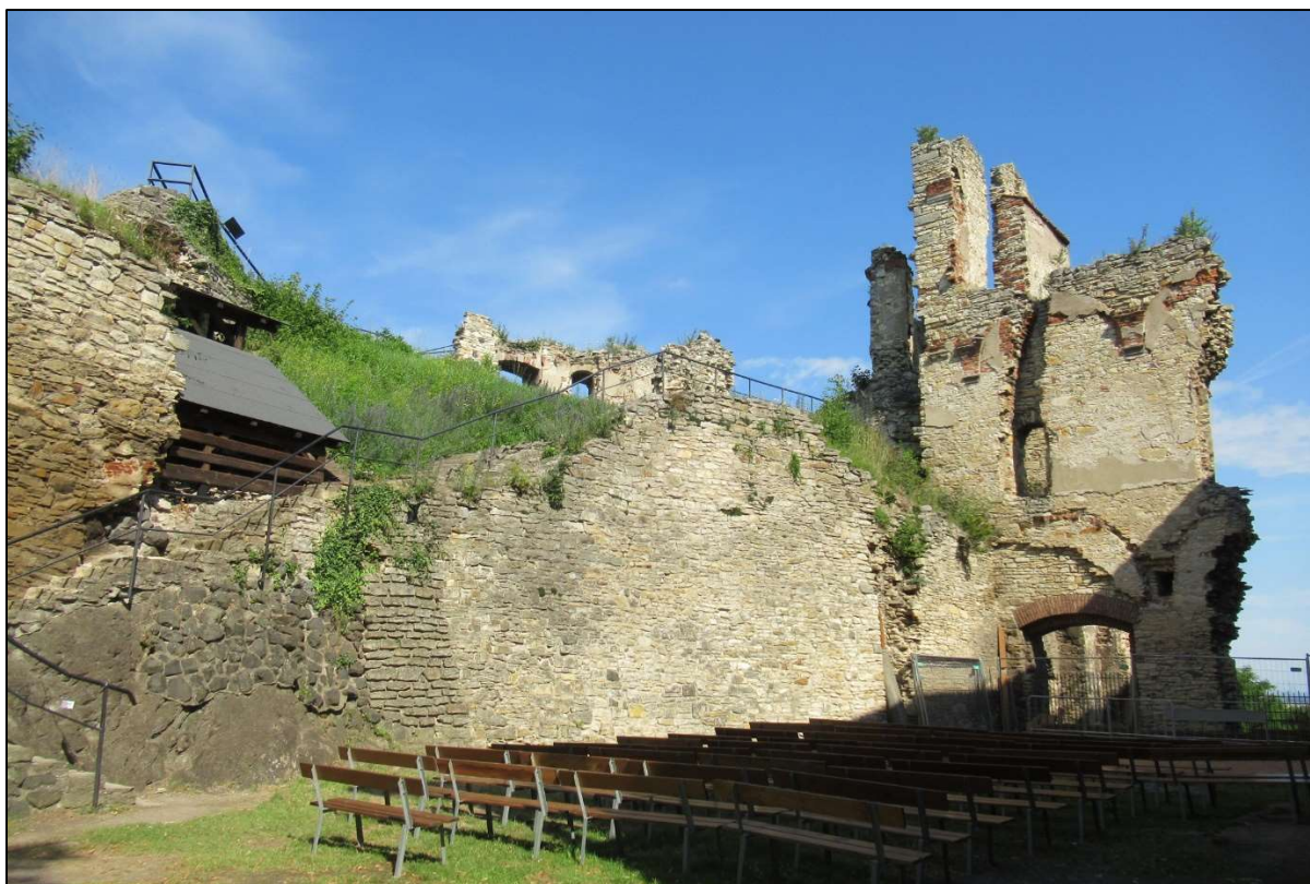
Foto 25. Areál „starého hradu“ a torzo „spojovacího křídla nového paláce“ Současný stav, pohled z hlavního nádvoří. Foto autor, 15. 7. 2020.
