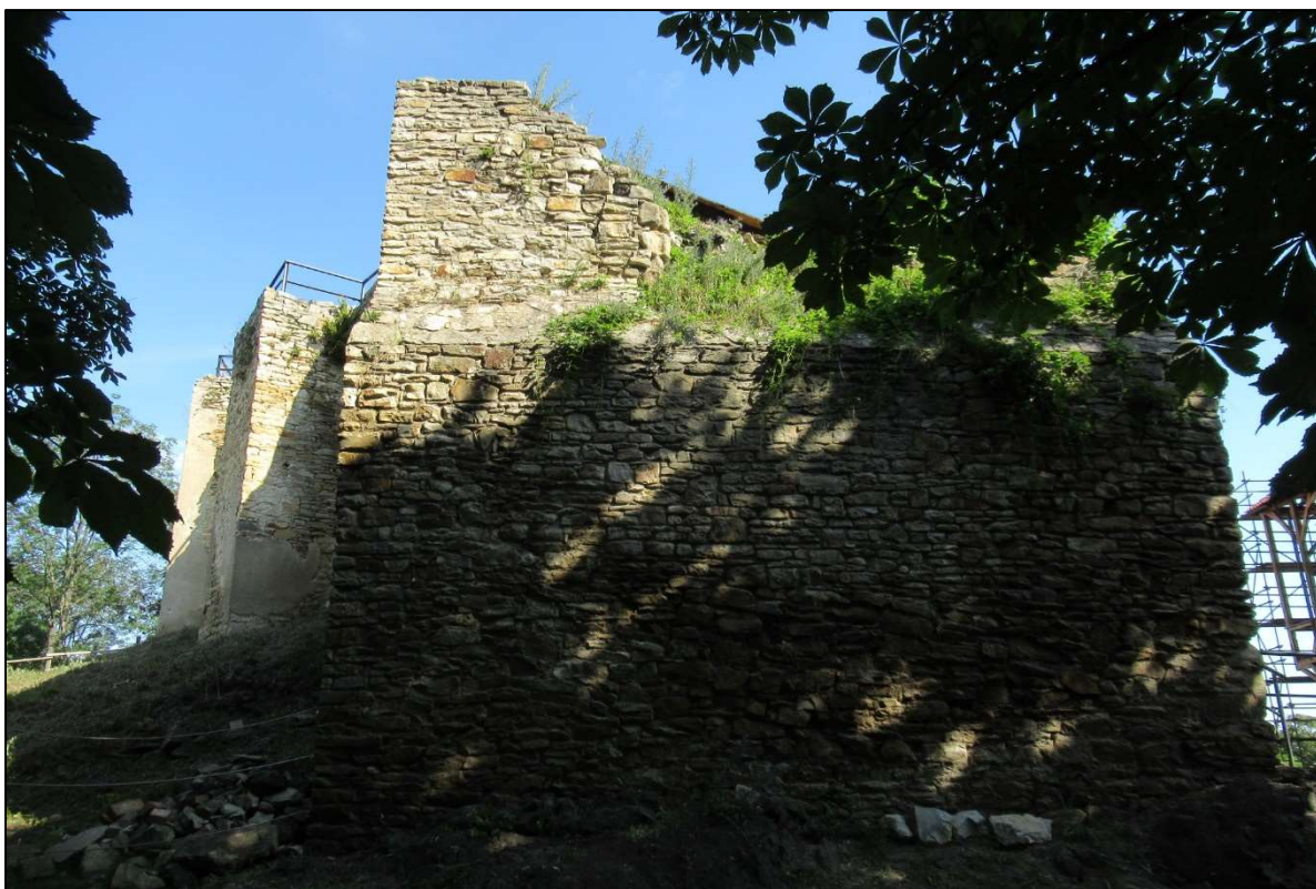
Foto 27. Jižní průčelí vstupní věže s pozůstatkem vpadliny pro padací most, vlevo „opěráky č. 1 a č. 2“. Současný stav, pohled z hlavního nádvoří. Foto autor, 15. 7. 2020.
