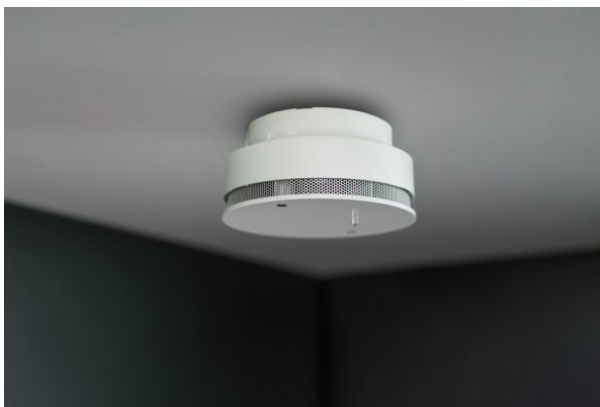
Obrázek 8: Detektor kouře připevněn ke stropu
