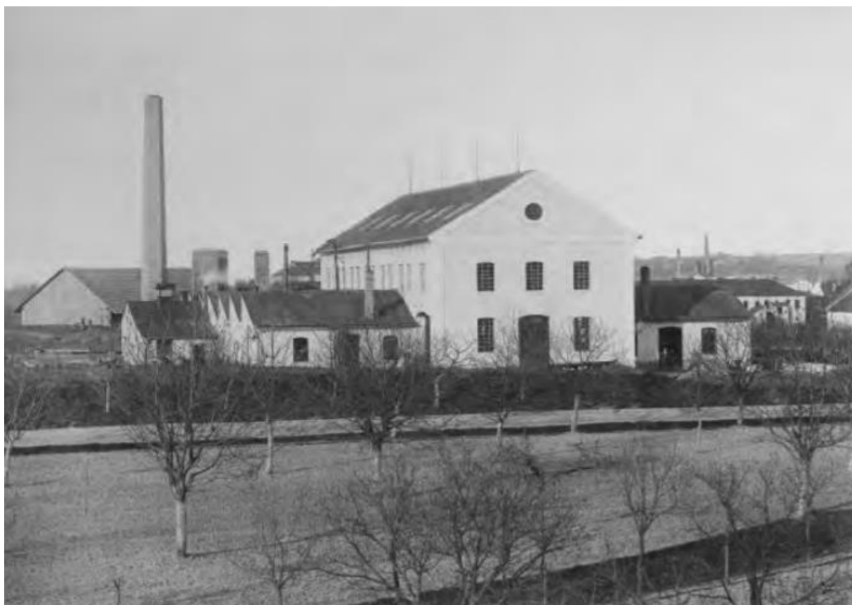
Obrázek č. 11 – Objekt nové továrny vystavěné roku 1885, která se nacházela v Čáslavské ulici.
