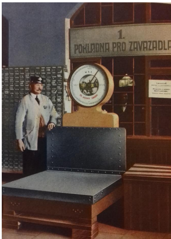
Obrázek č. 19 – Automatická váha W. A. S. pro podávání zavazadel na Wilsonově nádraží v Praze.
