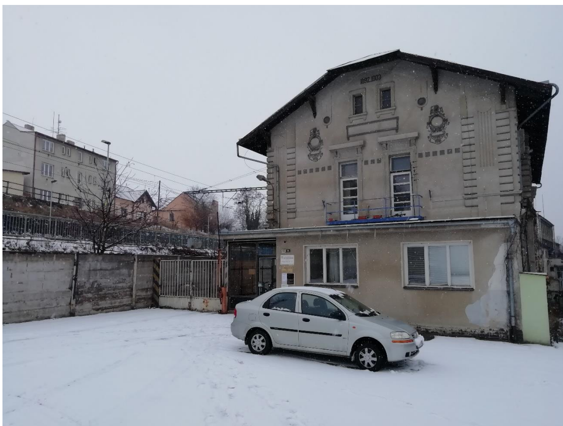
Obrázek č. 28 – Budova bývalé Wiesnerovy strojírný postavená v Kolíně – současnost.
