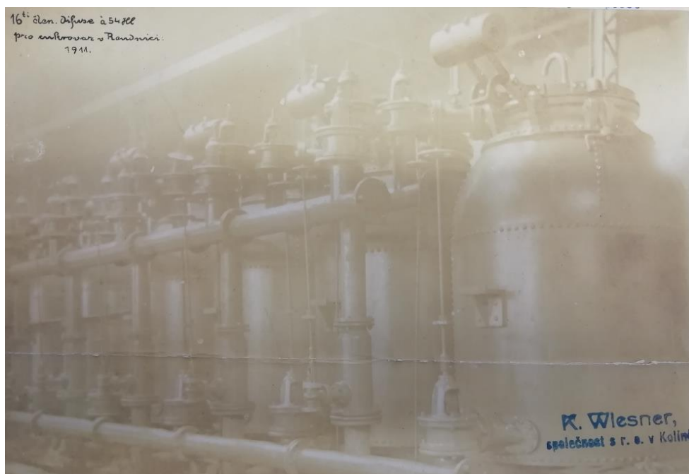
Obrázek č. 27 – 16-ti členná difusní baterie o obsahu 54 hl zhotovená ve 20. letech 20. století pro cukrovar v Roudnici nad Labem.
