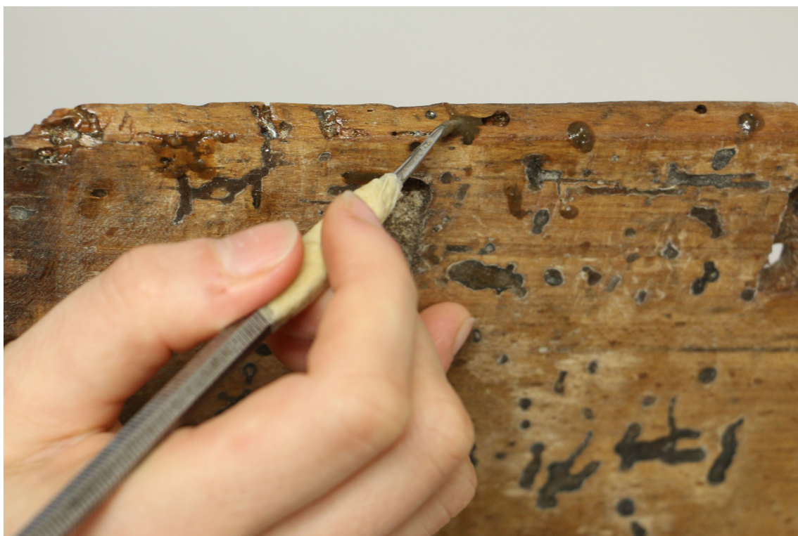
Obr. 66: Tmelení otvorů po dřevokazném hmyzu
