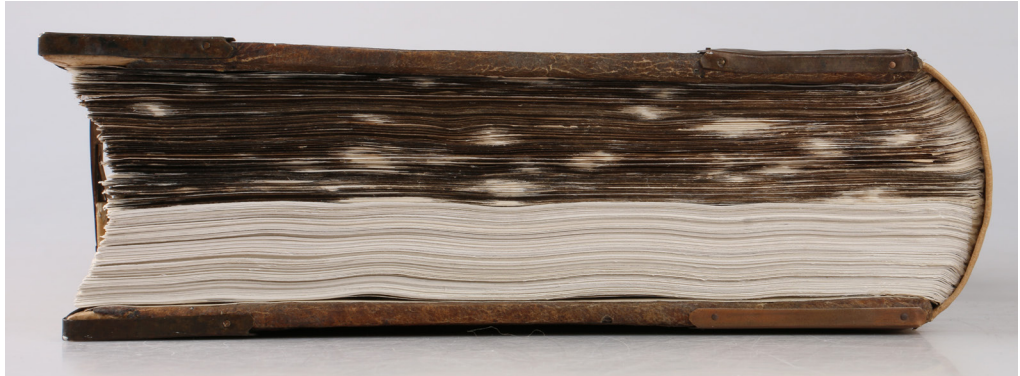
Obr. 22: Pohled na horní ořízku – stav před a po restaurování
