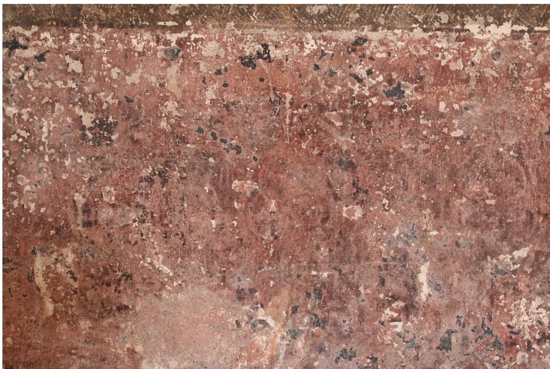
Obrázek 5: Detail červeno-černého šablonového dekoru. Pohled na druhotný tmel a zbytky vrstvy sazí.
