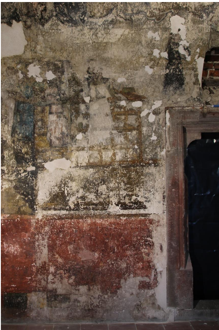
Obrázek 28: Stav díla po vytmelení. Celkový pohled.
