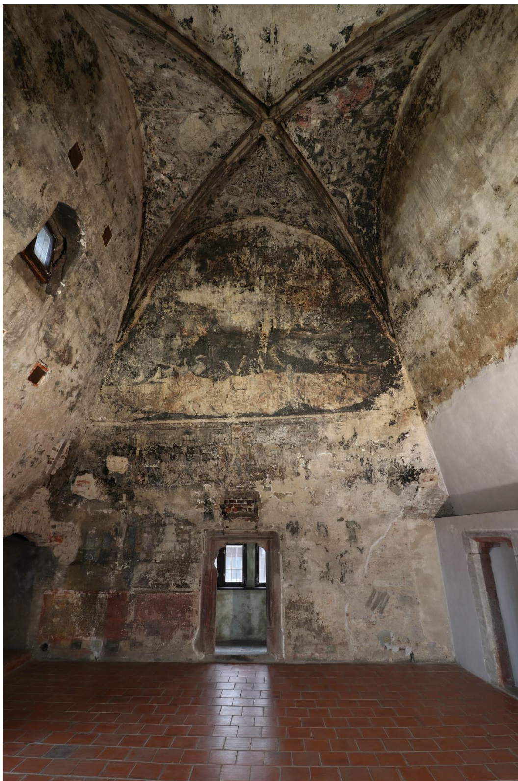
Obrázek 1: Celkový pohled na jihovýchodní stěnu před restaurováním.
