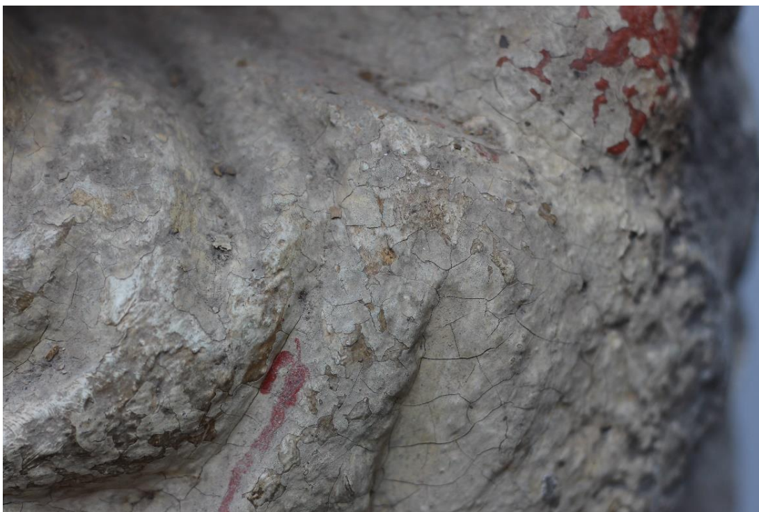
Obrázek 23 Stav před restaurováním – detail poškození – krakeláž povrchové úpravy
