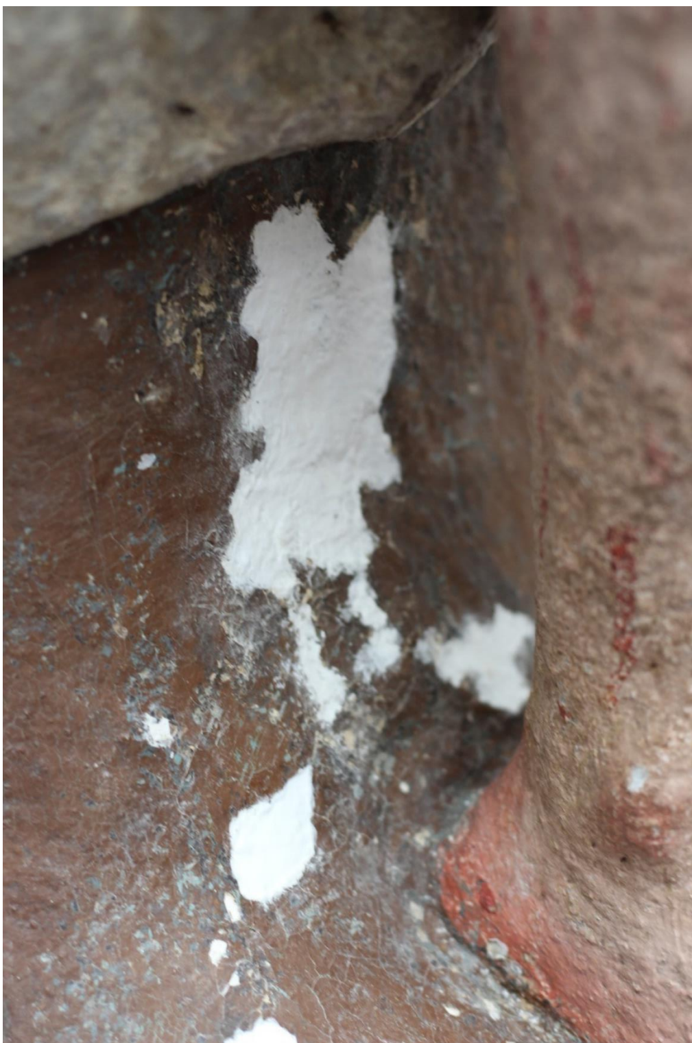
Obrázek 57 Detail – tmelení povrchové úpravy akrylátovým tmelem
