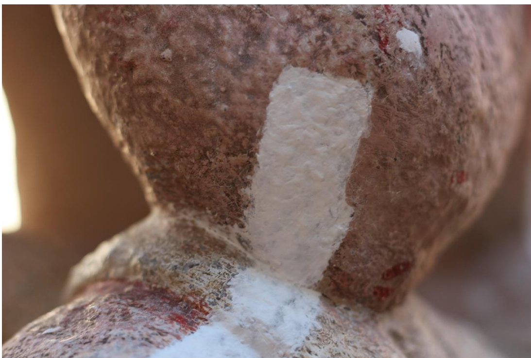
Obrázek 56 Detail – tmelení povrchové úpravy akrylátovým tmelem
