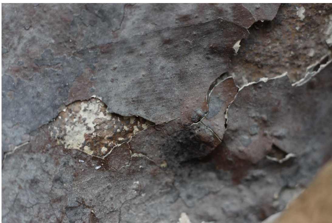
Obrázek 26 Stav před restaurováním –detail poškození – odlupující se povrchové vrstvy v oblasti podstavce
