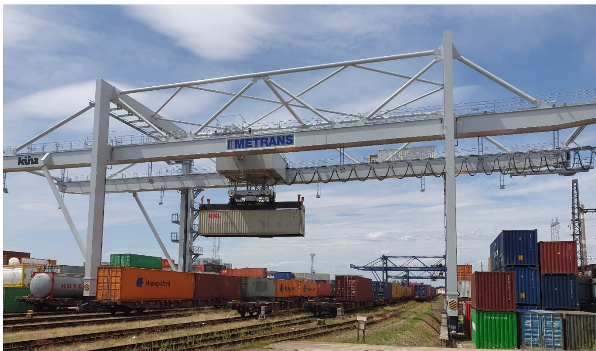
Obrázek 10 Portálový jeřáb RMG 13
