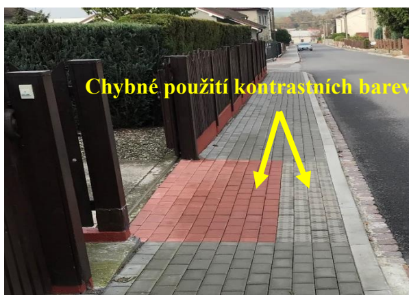
Obrázek 12 Chybné bezbariérové prvky v ulici Horní
