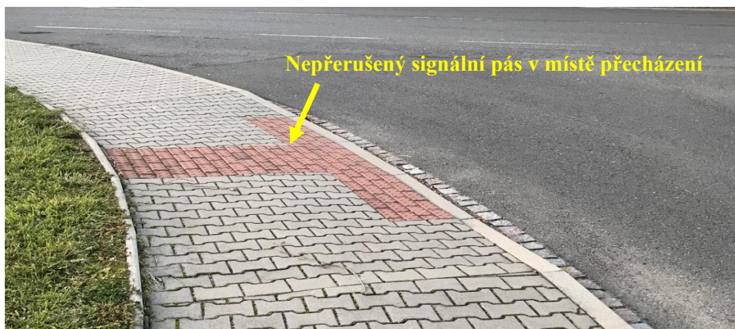
Obrázek 14 Chybné bezbariérové prvky v ulici Dlouhoveská
