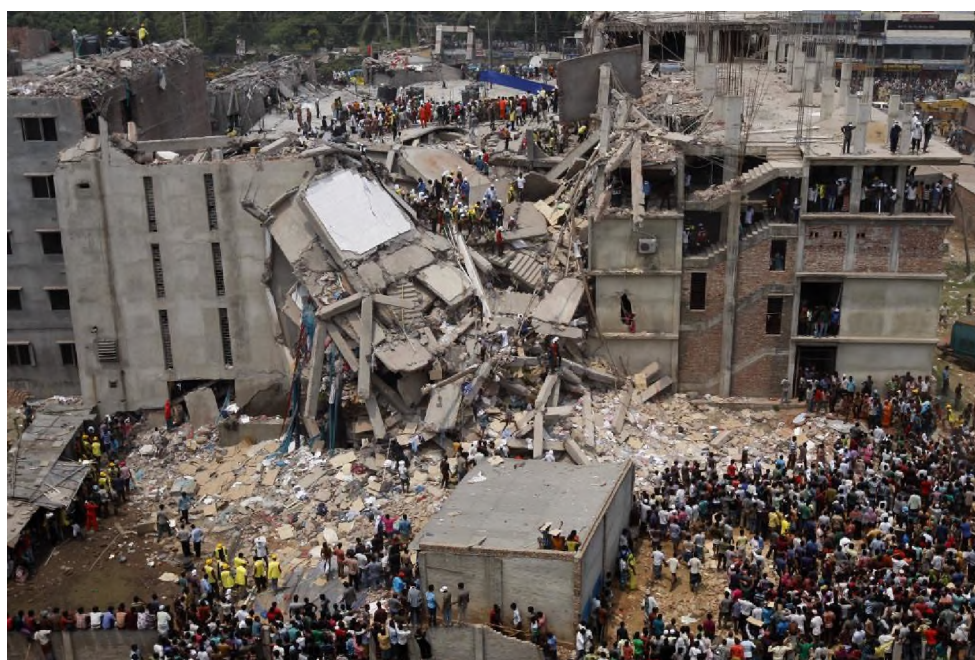
Obrázek 5 - Havárie budovy Rana Plaza (50)
