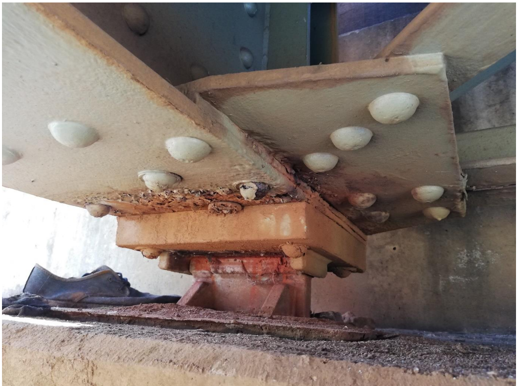
Obrázek 13 – Posuvné ložisko s odděleným podložiskovým prostorem od úložného prahu
