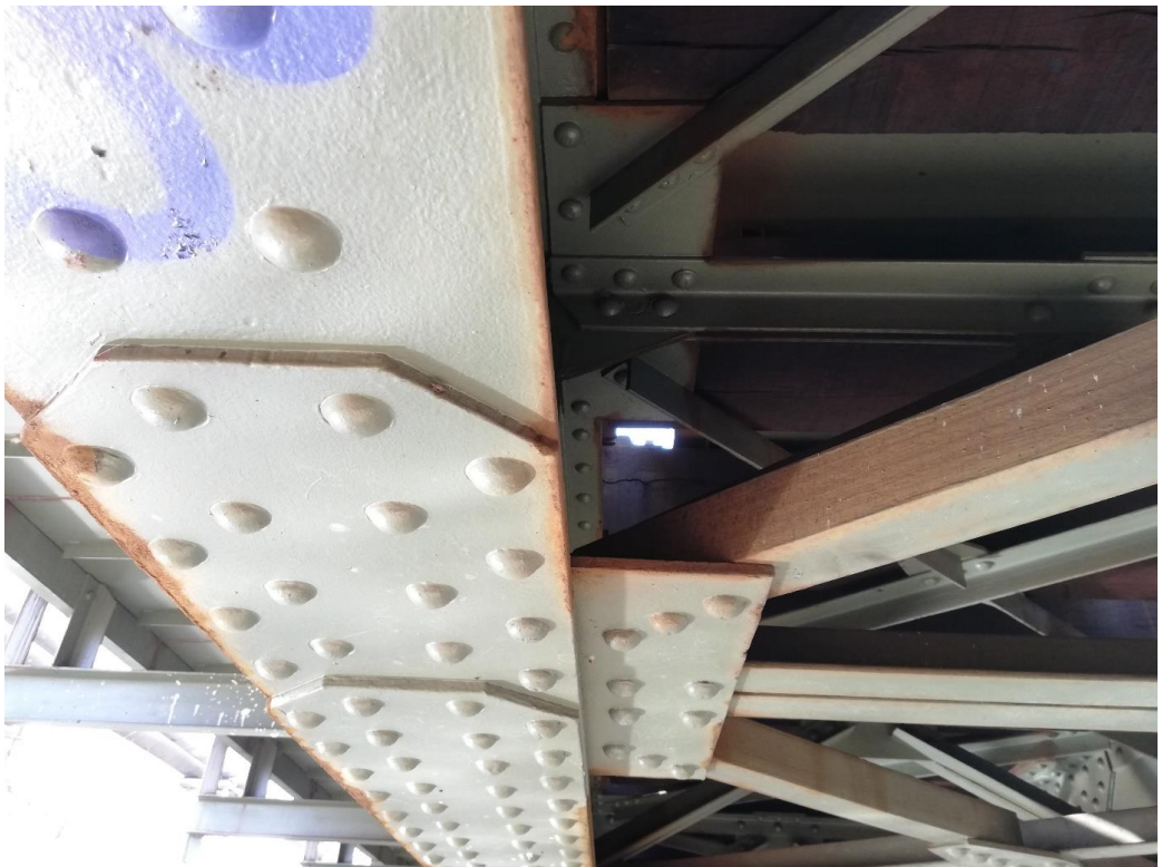
Obrázek 9 – Detail rozšíření pásnice
