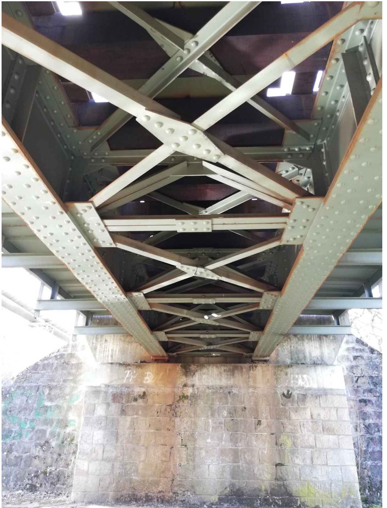
Obrázek 5 – Detail příčného ztužení hlavních nosníků
