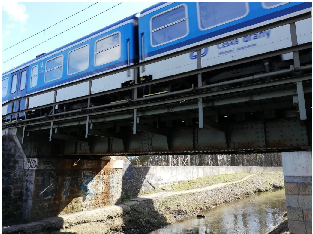
Obrázek 2 – Pohled na zatíženou mostní konstrukci
