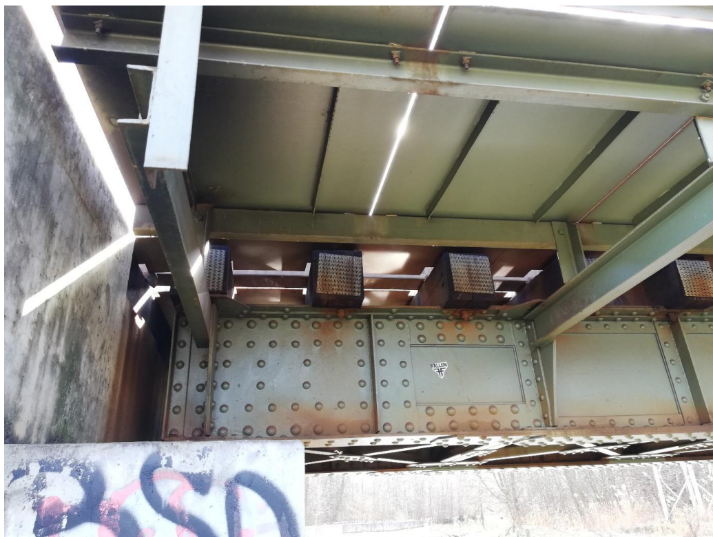
Obrázek 10 – Detail připojení mostnic k hlavním nosníkům
