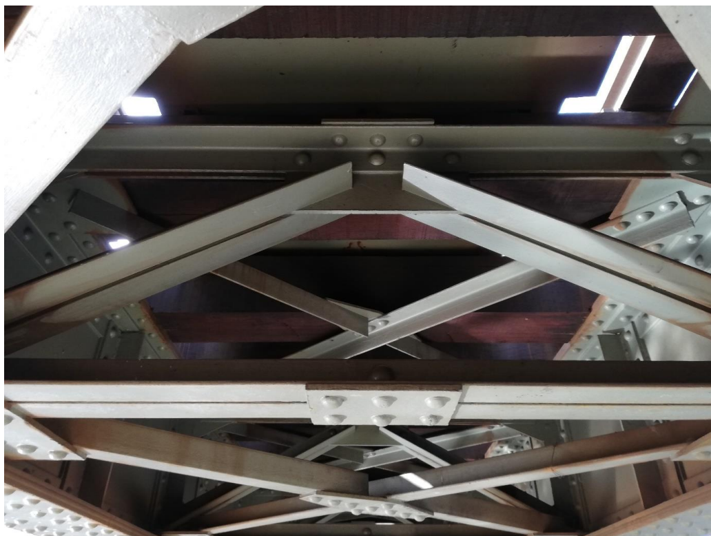
Obrázek 6 – Detail příčniku
