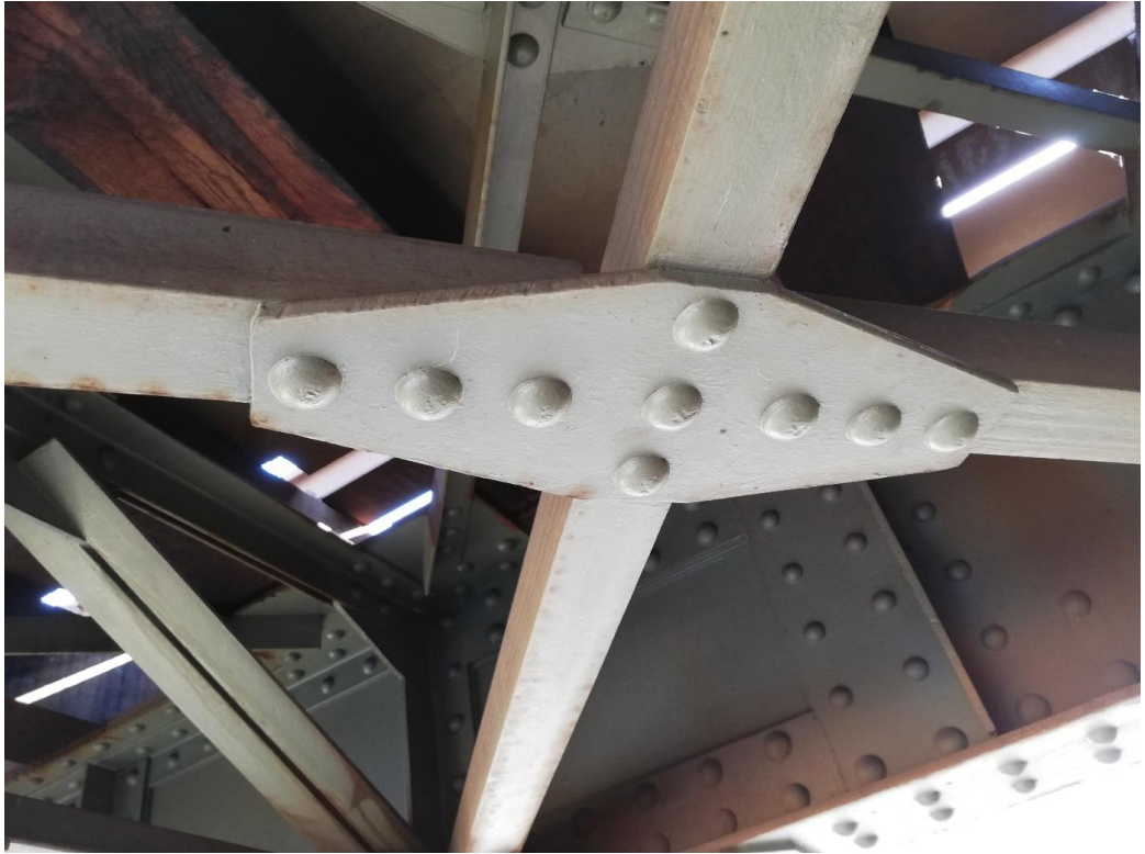
Obrázek 8 – Detail křížení brzdných ztužidel
