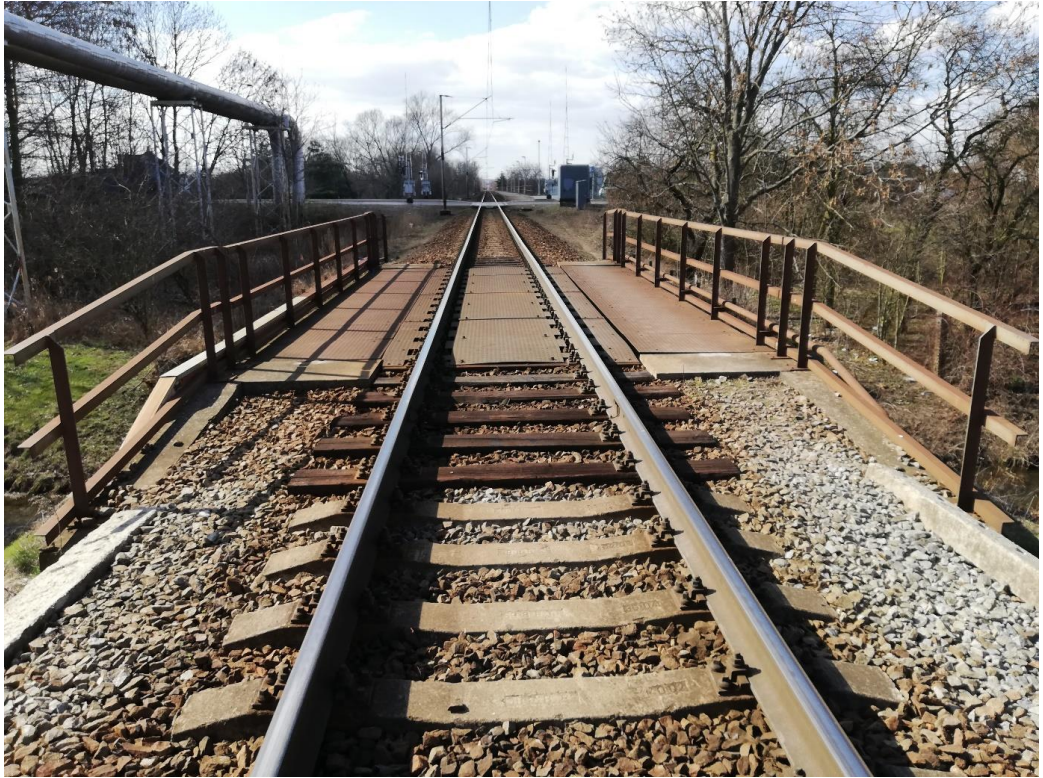
Obrázek 3 – Pohled na mostní svršek směr Chlumeck nad Cidlinou
