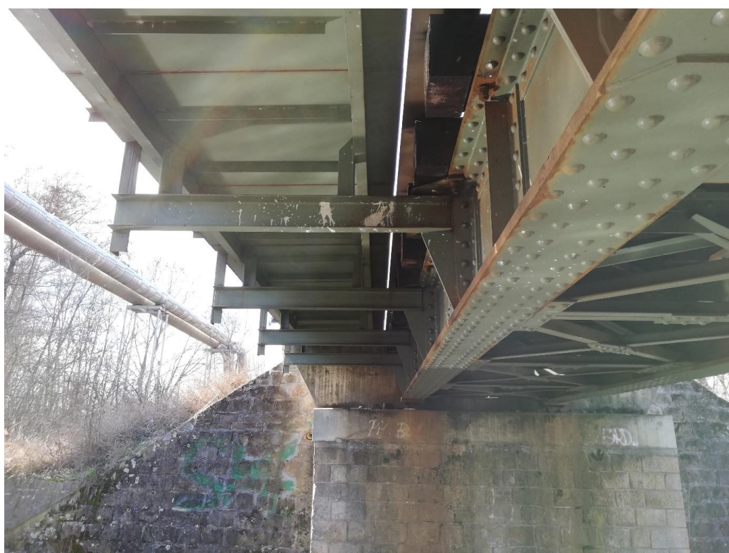
Obrázek 11 – Chodníkové konzoly
