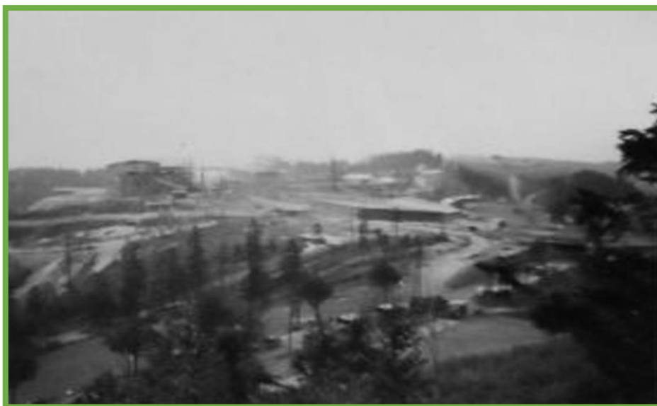
Obrázek 21: Unikátní snímek zachycující práce na pevnostním objektu Stachelberg (zdroj: vlastní archiv autorky).
