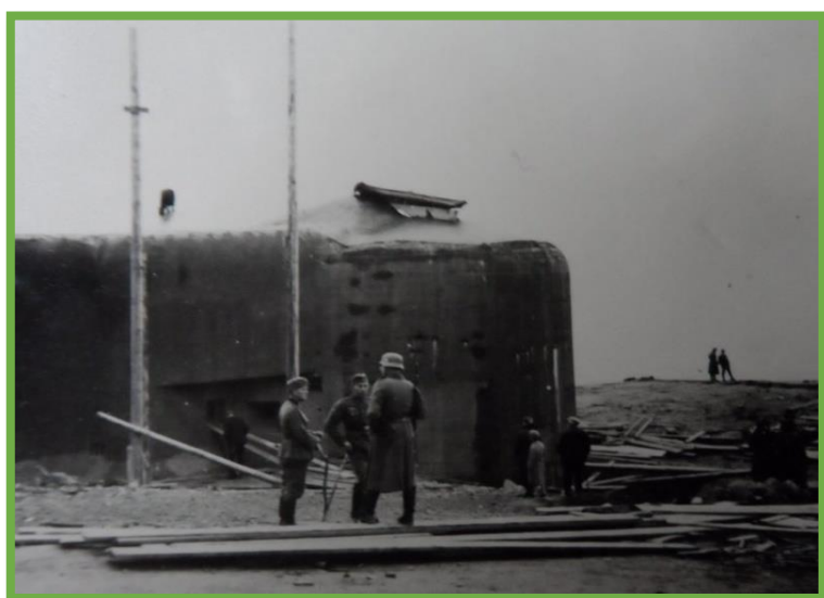
Obrázek 17: Jeden z pěchotních srubů T-St-S 73, projektován a vybudován jako pěchotní srub těžkého opevnění na Trutnovsku dělostřelecké tvrze Stachelberg (zdroj: vlastní archiv autorky).
