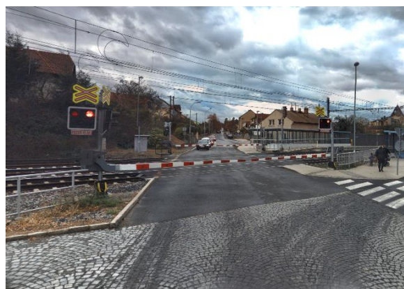
Obr. 6 Přejezd Úvaly, Praha východ (P4933)
