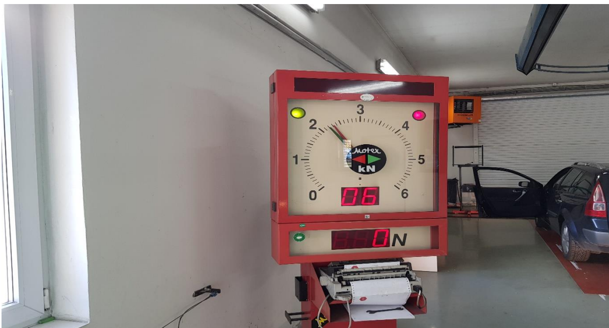
Obrázek 27 – Kontrolní stanoviště č. 3, ukazatele brzdné síly na nápravě
