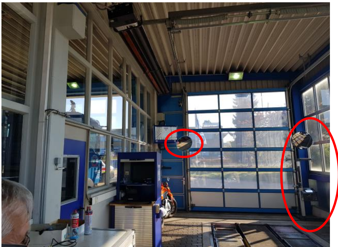
Obrázek 53 – Kontrola osvětlení na stanovišti č. 4
