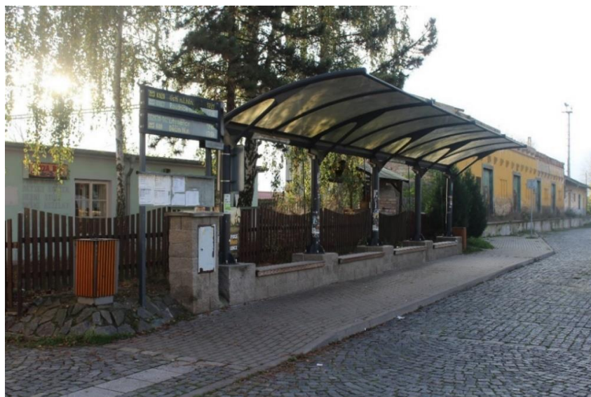
Obrázek 7 - Zastávka Bohušovice n. Ohří, žel. st.
