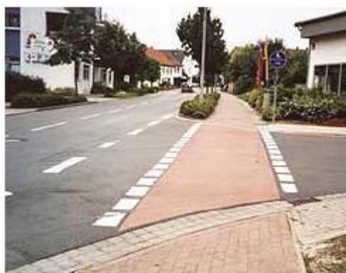
Obrázek 21. Problematické křížení pozemních komunikací
