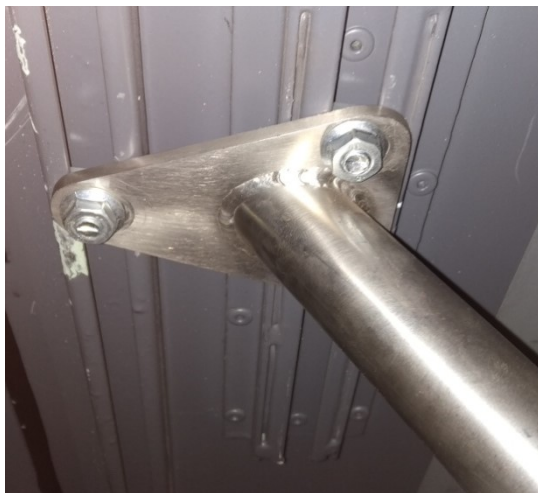
kotvení do střechy HS – schováno krytem
