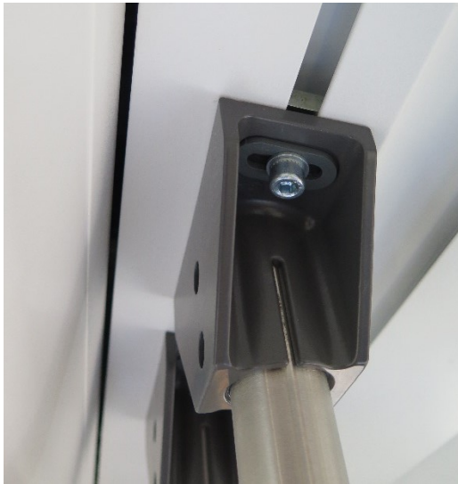
kotvení do obložení stropu - viditelné v interiéru
