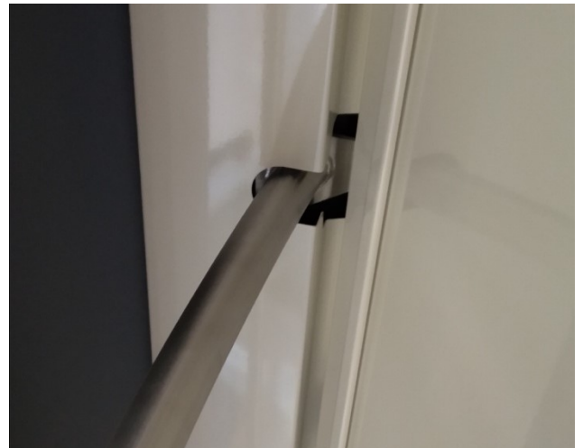
kotvení do střechy HS – schováno krytem
