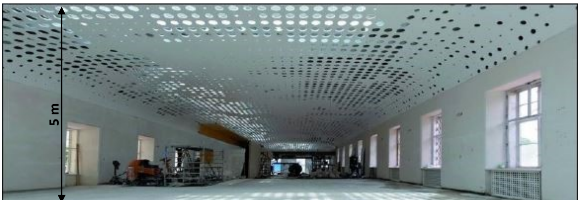
světlý klenutý strop s perforací pro prostup denního světla (návštěvnické centrum zámku Schönbrunn) [21]
