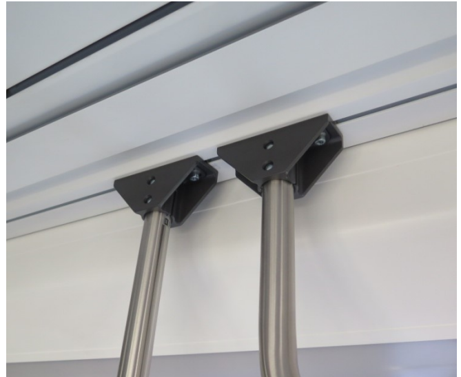
kotvení do obložení stropu - viditelné v interiéru
