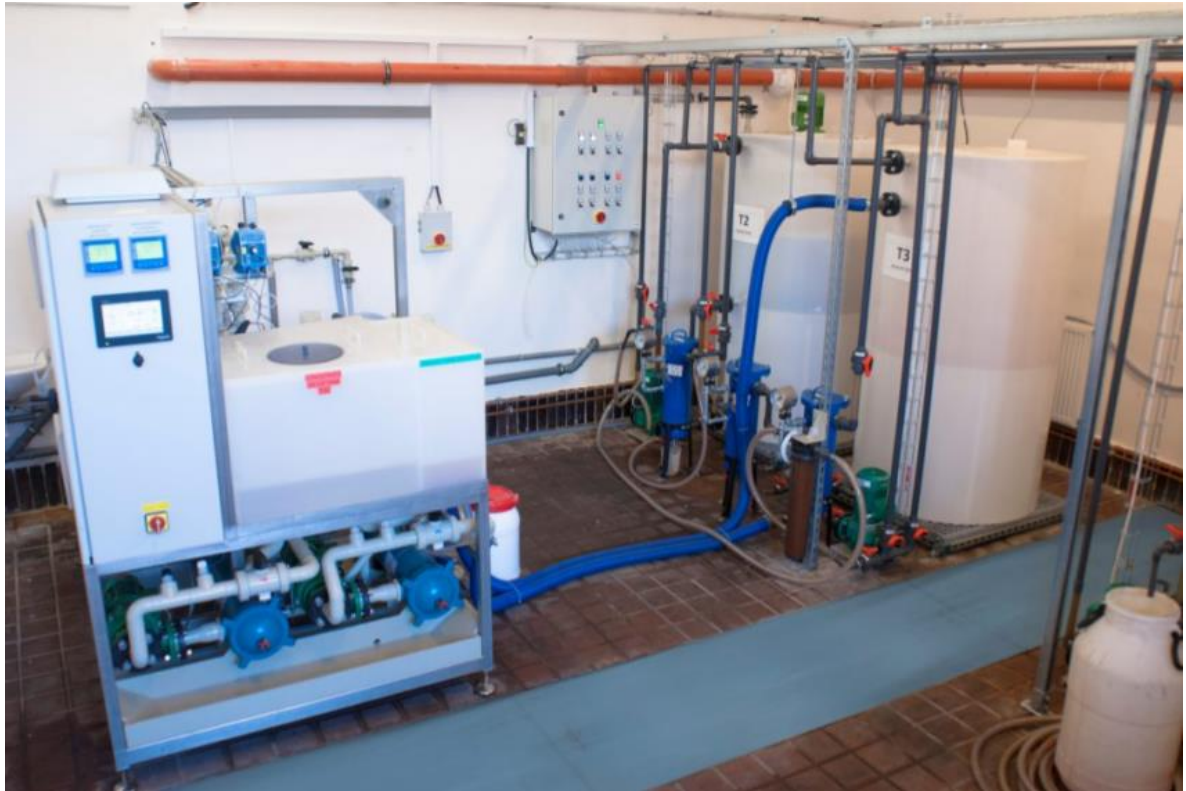
Obrázek 5: Recyklační linka pro chladicích kapaliny RALEX® ELPU P2 1xEDR-X/100-0.8 od firmy MemBrain (MemBrain, nedatováno)
