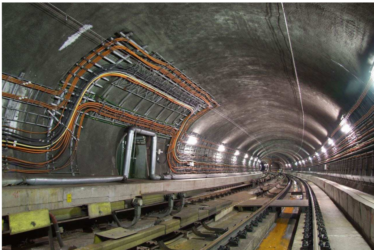
Obr. 26: Dvojkolejný tunel úseku IV.B vystavěný NRTM [8]
