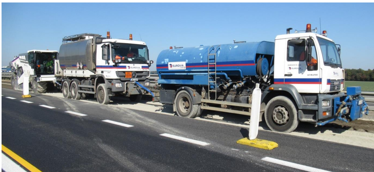
Obrázek 8 - Recyklační kolona (zemní fréza/recyklér, zásobní vozidlo na asfaltové pojivo, kropicí vůz)
