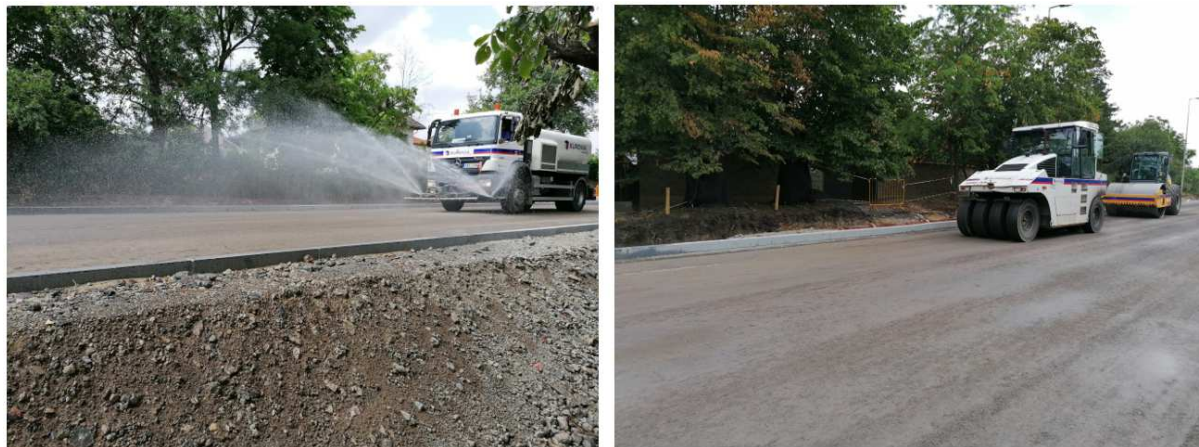
Obrázek 75 – Ošetřování povrchu kropením a následné dohutnění pneumatickým válcem [1]
