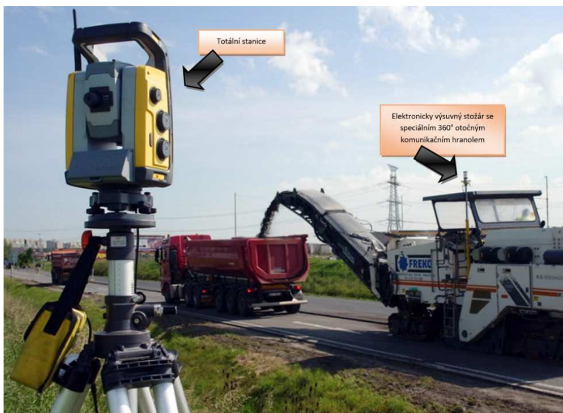
Obrázek 9 – Využití 3D technologie při frézování krytu vozovky [23]
