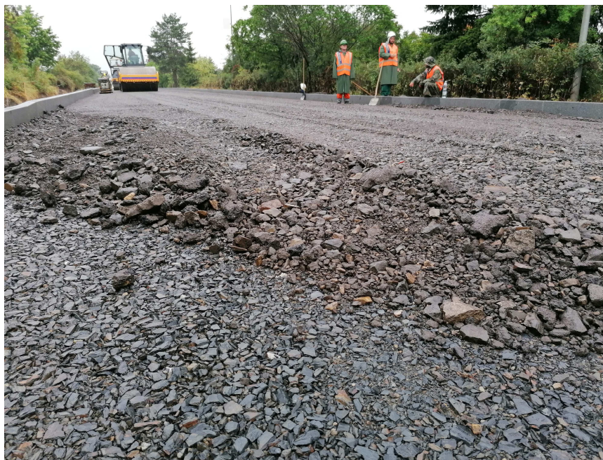
Obrázek 70 – Hutnění rozhrnutého R-materiálu [1]
