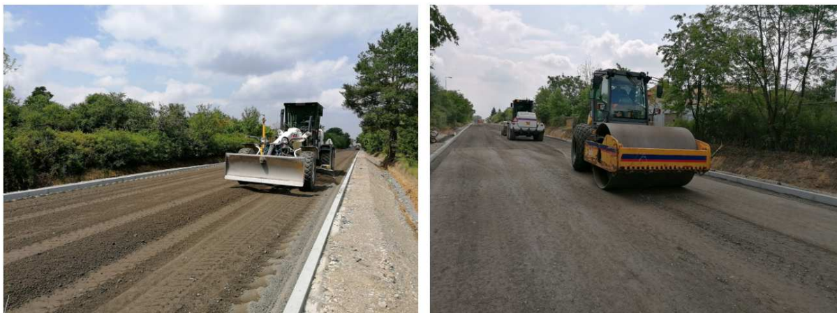
Obrázek 74 – Urovnání grejdrem a následné hutnění zemním válcem [1]
