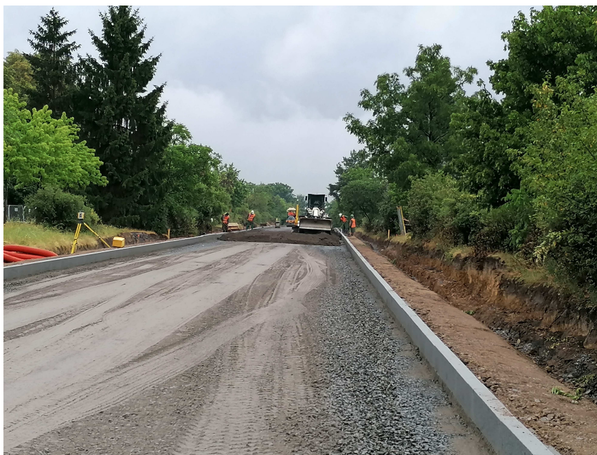
Obrázek 69 – Rovnění navezeného R-materiálu pomocí grejdrů [1]
