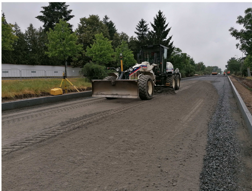
Obrázek 68 – Roztažení kameniva frakce 0/4 mm pomocí grejdru [1]
