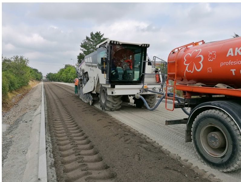
Obrázek 72 – Zemní fréza s kropicí [1]
