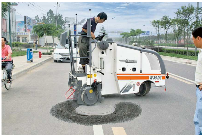
Obrázek 7 – Využití speciální silniční frézy v blízkosti kanalizačního poklopu [21]
