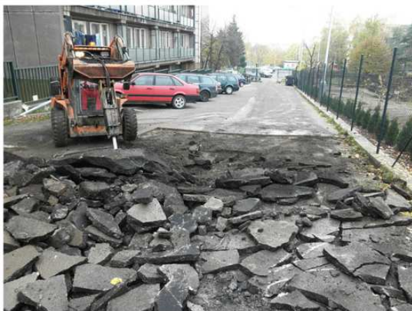
Obrázek 6 – Technologie získávání asfaltového recyklátu z konstrukce vozovek [20]; [21]
