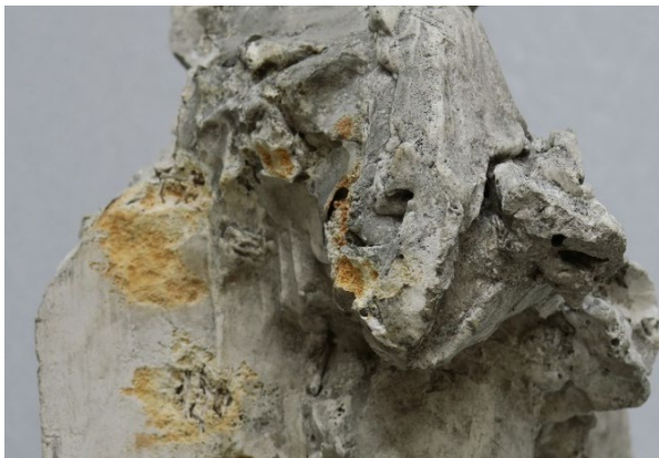
Stav po očištění
