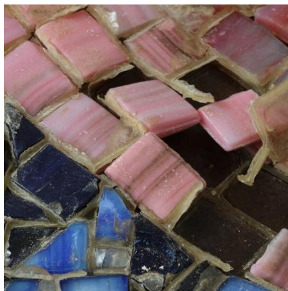
Obr. 8: Detail uvolněných mozaikových kostek u mozaiky Racek . Stav před restaurováním.
