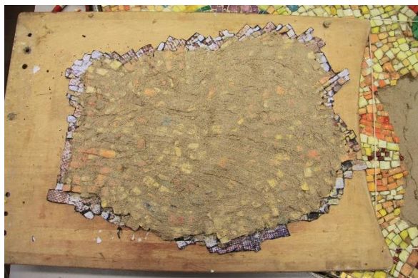
Obr. 48: Průběh osazování doplňku. Rubová strana doplňku s tenkou vrstvou osazovací malty.
