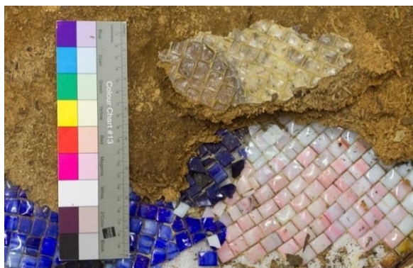
Obr. 16: Průběh snímání dřevotřískové desky s ulpívající vrstvou epoxidového lepidla.
