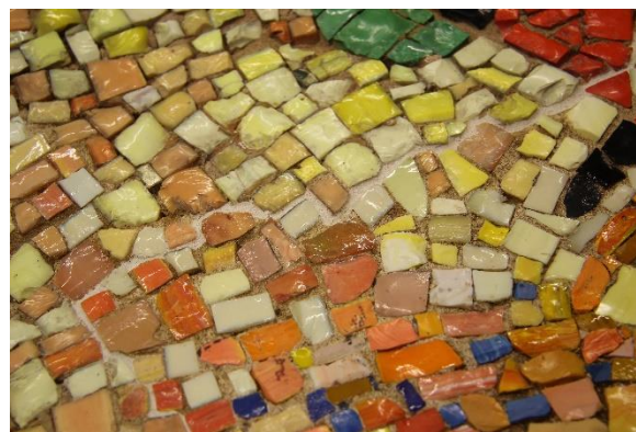
Obr. 53: Detail rekonstruované části mozaiky – světlá spára oddělující nový doplněk od zbytku mozaikového motivu.
