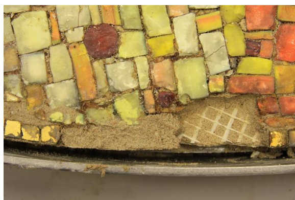
Obr. 40: Průběh upevňování uvolněných částí mozaiky – nanášení osazovací malty.
