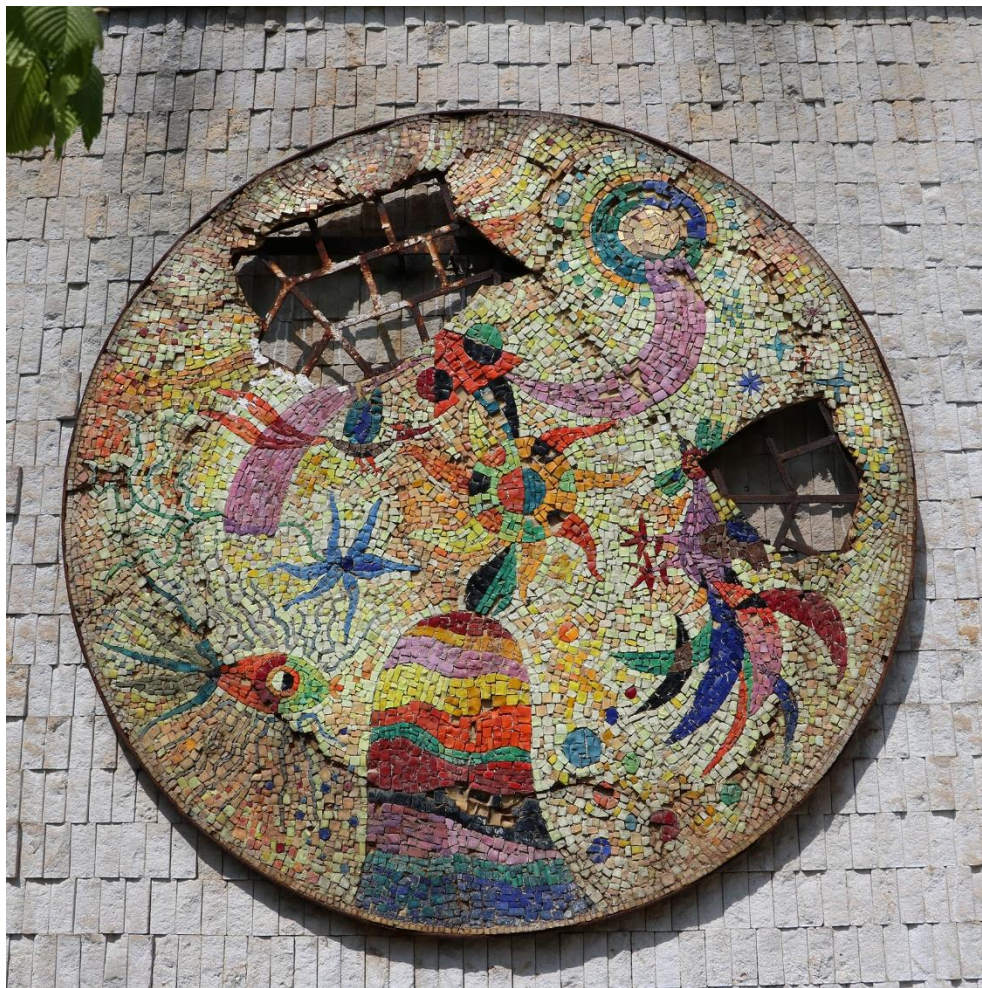
Obr. 1: Celkový pohled na mozaiku Žena-květ na stěně atria obchodního centra Luna v Chomutově. Patrné rozpraskání panelu a ztráta rozsáhlých částí. Stav před restaurováním.
