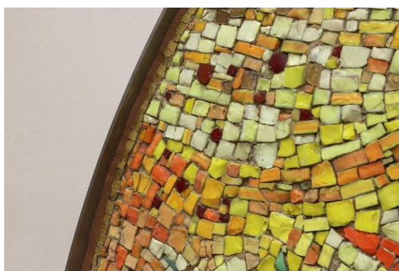
Obr. 38: Detail obvodové dilatační spáry z polyuretanového tmelu.
