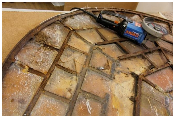
Obr. 12: Průběh odstraňování zkorodované železné konstrukce z rubu mozaiky Žena-květ . Konstrukce musela být nejprve nařezána úhlovou bruskou na menší části a poté ji bylo možné odtrhnout od epoxidového lože.
