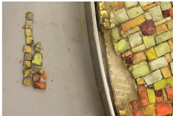
Obr. 39: Průběh upevňování uvolněných částí mozaiky. Z konsolidovaného místa byly vyjmuty mozaikové kostky a byla redukována tloušťka pískové omítky.
