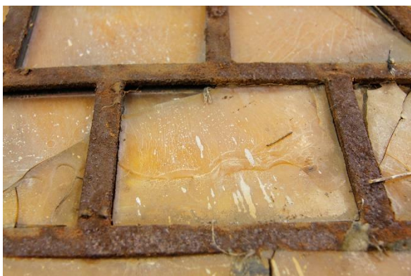
Obr. 3: Detail rubové strany mozaiky Žena-kvěť , stav před restaurováním. Na snímku je patrný způsob vytváření podložky pro mozaikové sklo – postupné zalévání a vrstvení epoxidové pryskyřice.
