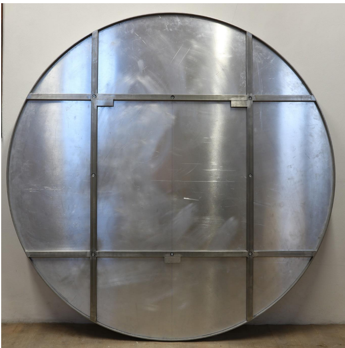
Obr. 31: Celkový pohled na rubovou stranu kompozitního panelu s mozaikou Žena-květ . Ke skleněné mozaice osazené pomocí souvrství omítek a polymerního adheziva na hliníkovou voštinovou desku je šrouby upevněna odnímatelná nerezová nosná konstrukce.
