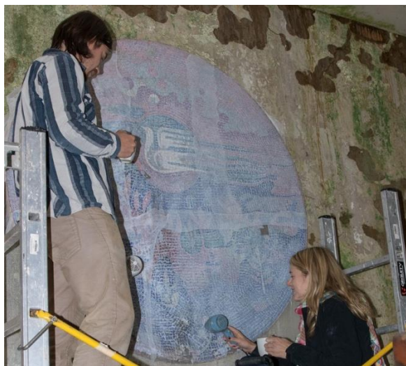
Obr. 11: Aplikace ochranného přelepu z gázy a lepidlové směsi na bázi akrylátové disperze a derivátu celulózy.
