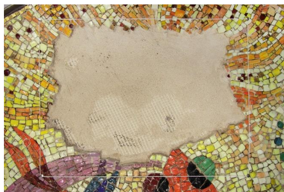
Obr. 47: Rekonstruovaná část mozaiky Žena-květ po zbroušení omítkových vrstev.
