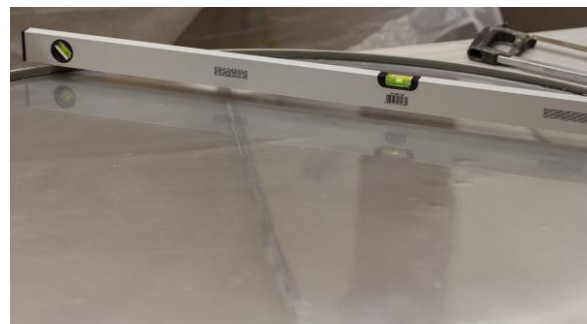
Obr. 33: Podkladová deska musí být při roztírání epoxidové pryskyřice v naprosté rovině, aby nedošlo k nahromadění pryskyřice na jedné straně.
