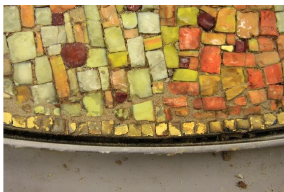
Obr. 41: Průběh upevňování uvolněných částí mozaiky – stav po opětovném osazení mozaikových kostek do nově nanesené osazovací malty.
