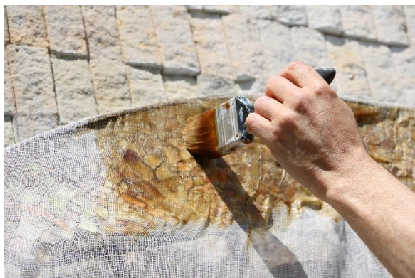
Obr. 9: Aplikace ochranného přelepu z gázy a lepidlové směsí na bázi klišu, tzv. colletty .
