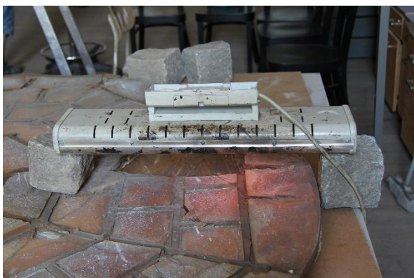
Obr. 14: Průběh odstraňování epoxidového souvrství z rubové strany mozaikových kostek. Nahřívání epoxidového souvrství infračerveným zářičem.
