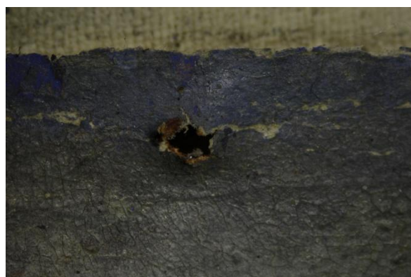
Obr. 19 Perforace papírové podložky s korozními produkty po hřebíku (zvětšeno 10×)
