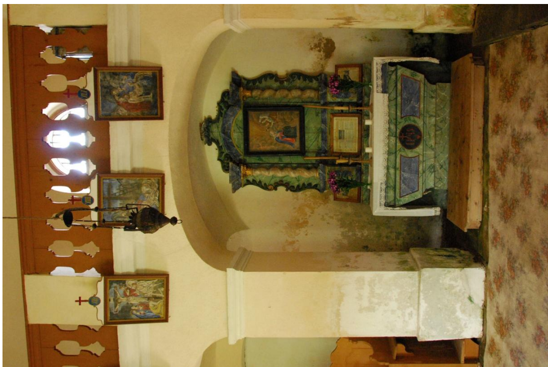
Obr. 3 Interiér kaple Panny Marie před rekonstrukcí, severní stěna, způsob umístění křížové cesty (foto Hugo Sedláček, 2010)
