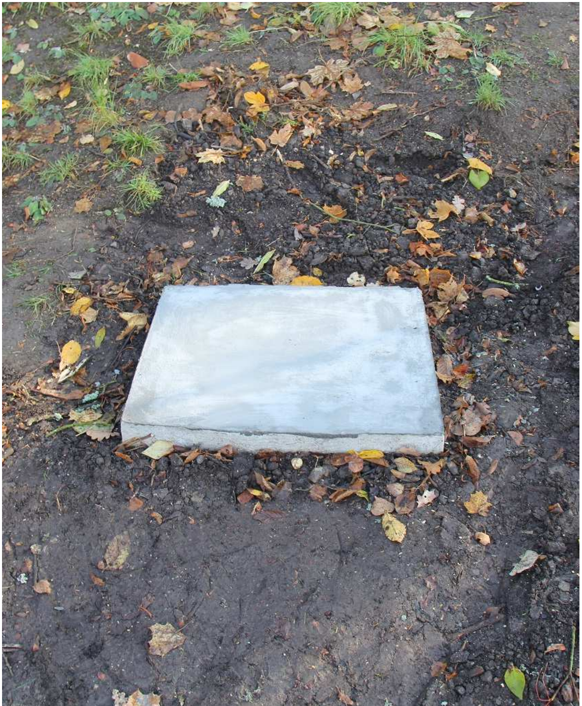
Obr. 90 - Betonový základ pod podstavec
