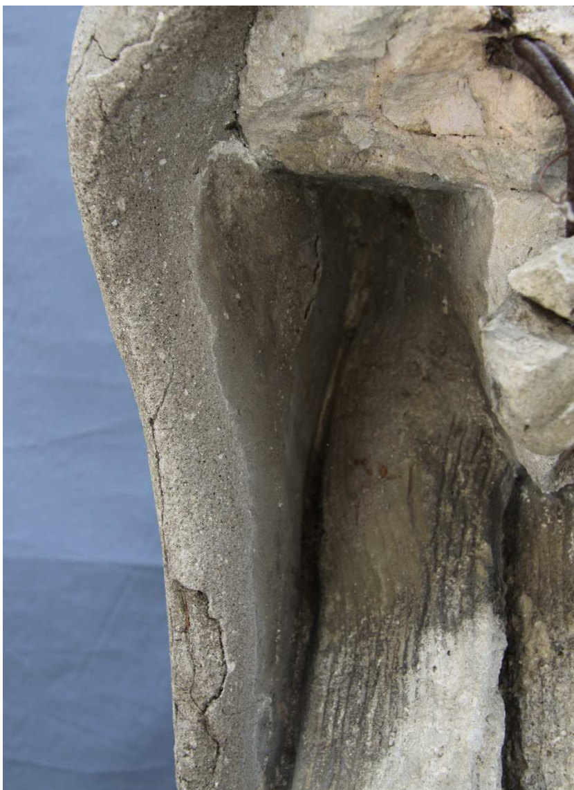
Obr. 54 - Historický tmel u pravé paže (stav před restaurováním)
