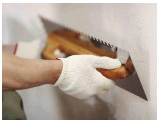
Obrázek 16 Aplikace tmele EP-0020 [42]
