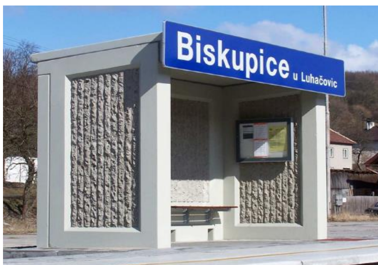
Obrázek 48 Betonový nástupištní přístřešek (ŽPSV, 2019)
