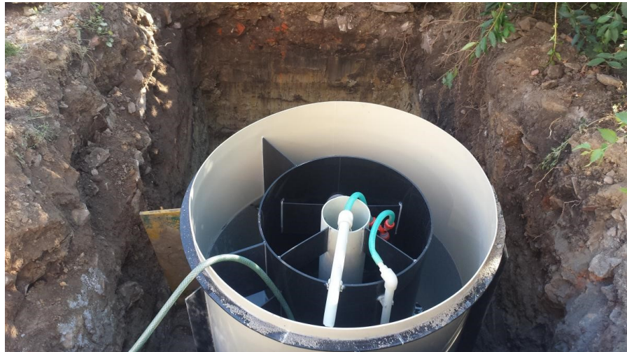
Obrázek 4: Čistírna odpadních vod
