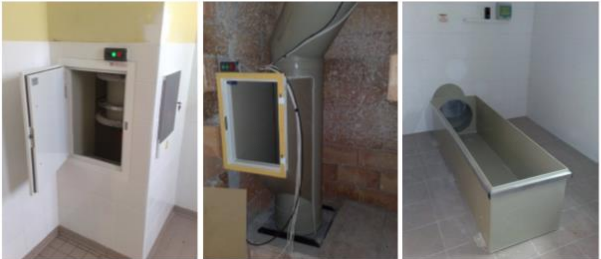
Obrázek 18 Realizace shozu prádla (R-plast, 2019, upraveno autorem)
