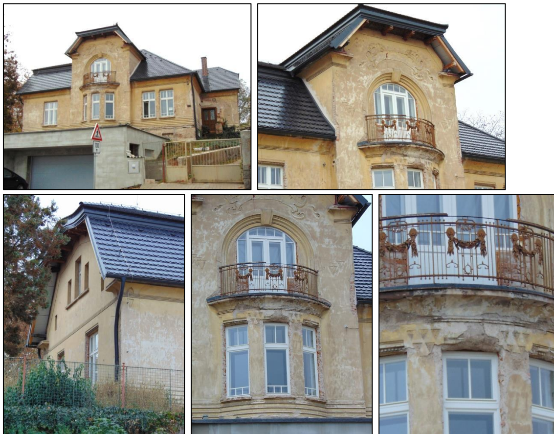
Předměřice nad Labem, ul. Obránců míru čp. 19 (Průčelí s pravým bokem; Detail rizalitu – pološtit; Levá štítová strana; Detail rizalitu – přízemí s balkonovým dílem; Detail dekorů balkonového dílu)
