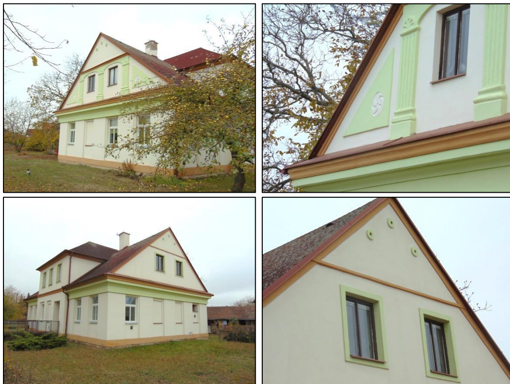
Černilov čp. 139 (Levá štítová strana; Detail levého štítu; Průčelí s pravou štítovou stranou; Detail pravého štítu)
