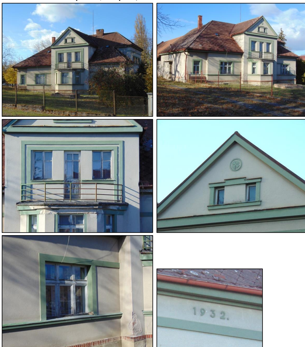
Librantice čp. 28 (Průčelí s pravým bokem; Průčelí s levým bokem; Detail rizalitu; Štít rizalitu; Orámování okenního otvoru v přízemí; Letopočet)
