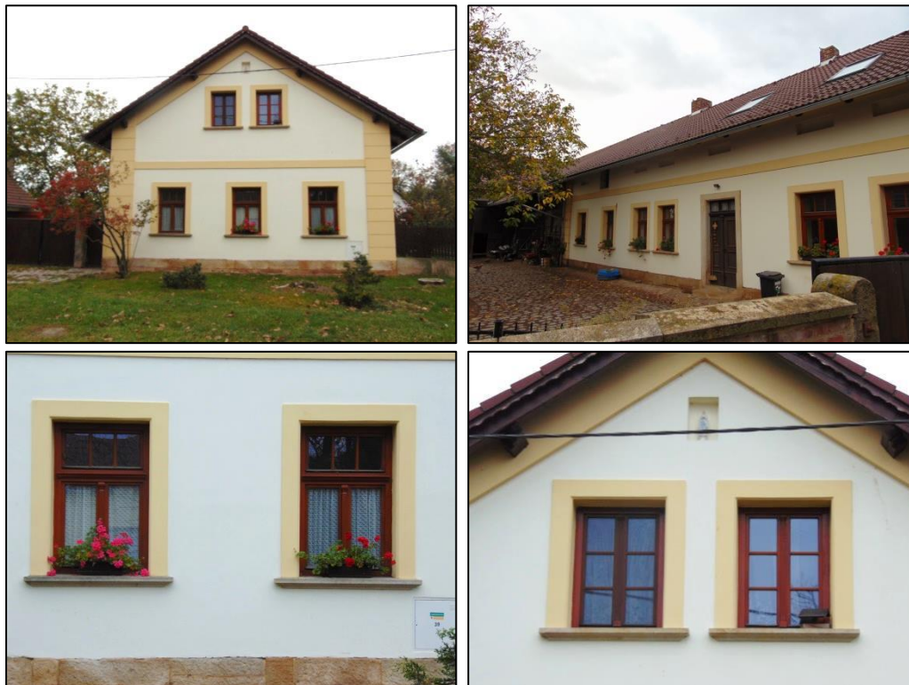
Plačice, ul. Vlčkovická čp. 39/84 (Průčelí; Levá delší strana; Okenní šambrány v přízemí; Detail štítu)
