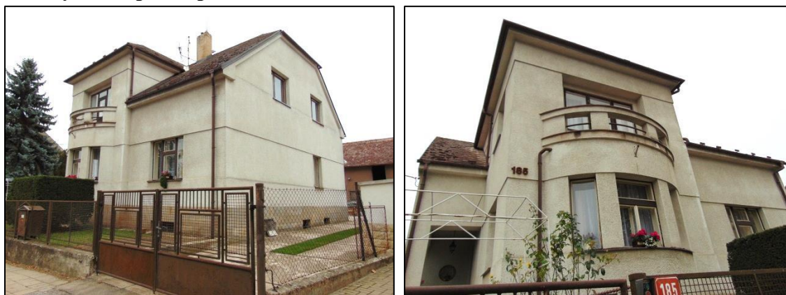
Stěžery, ul. Lipová čp. 185 (Průčelí s pravým bokem; Detail průčelí s levým bokem)
