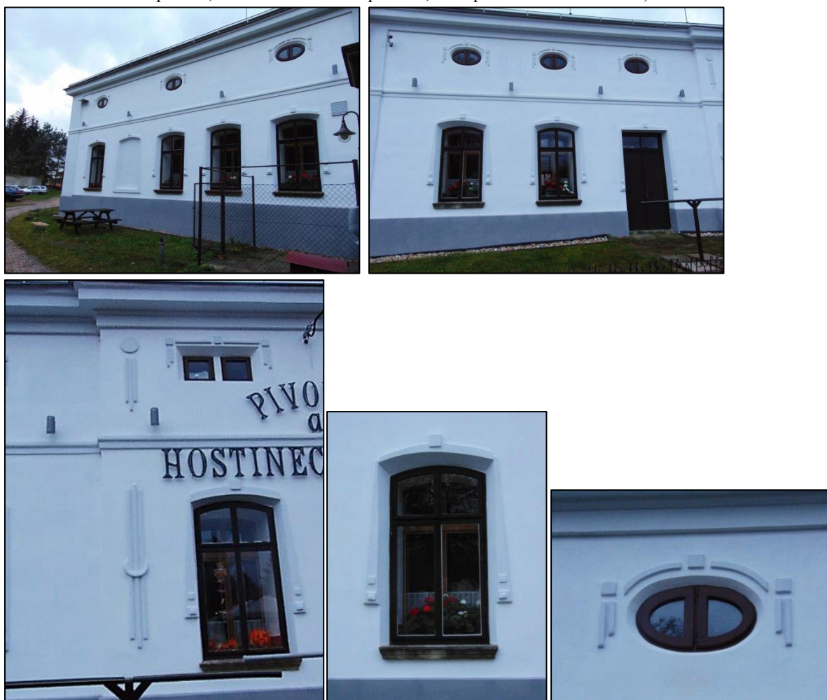
Běleč nad Orlicí čp. 2 – Hospoda (Levá kratší strana; Levý díl průčelí; Detail nároží a mezipatra středového dílu průčelí; Okenní šambrána v přízemí; Mezipatrové oválné okénko)
