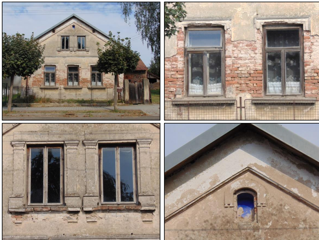
Všestary čp. 61 (Průčelí; Okenní šambrány v přízemí; Okenní šambrány ve štítu; Detail štítu)
