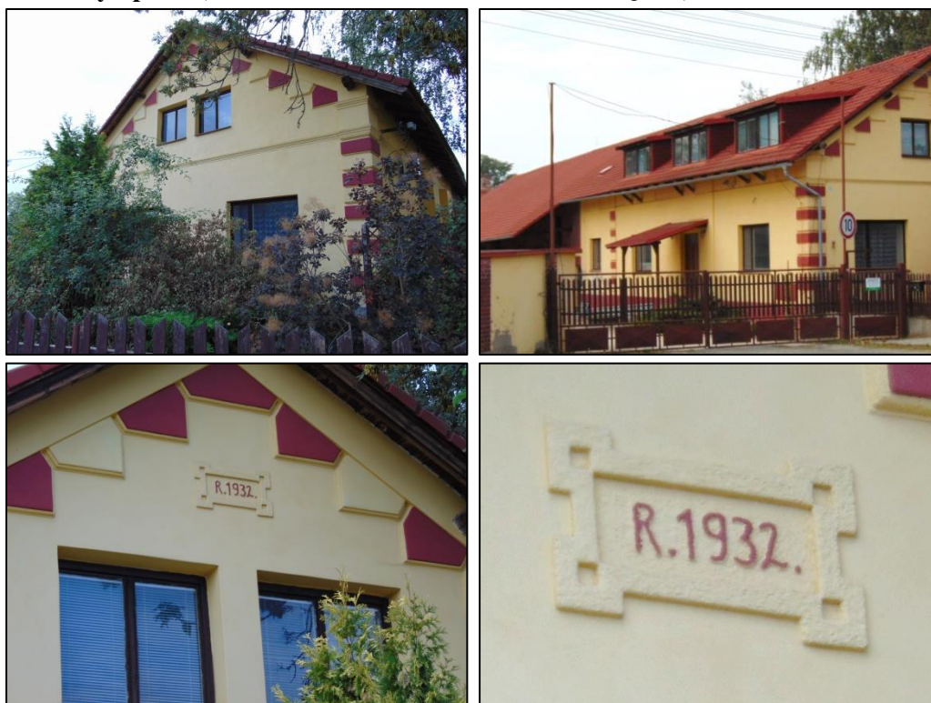
Všestary čp. 34 (Průčelí; Levá delší strana; Detail štítu; Letopočet)
