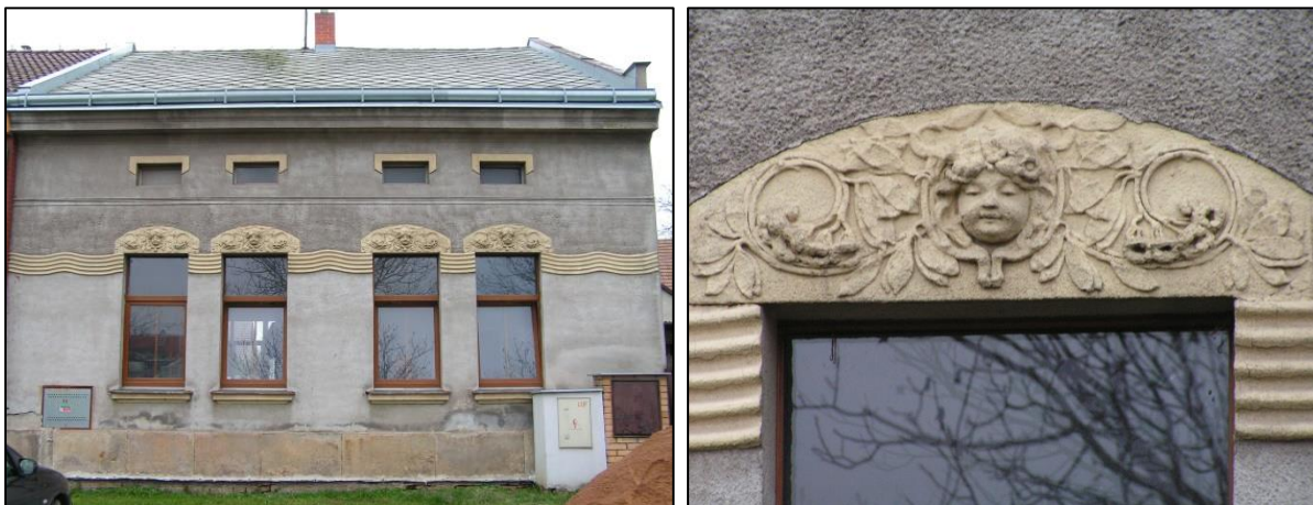
Vlčkovice čp. 42 (Průčelí; Nadokenní dekor v přízemí)
