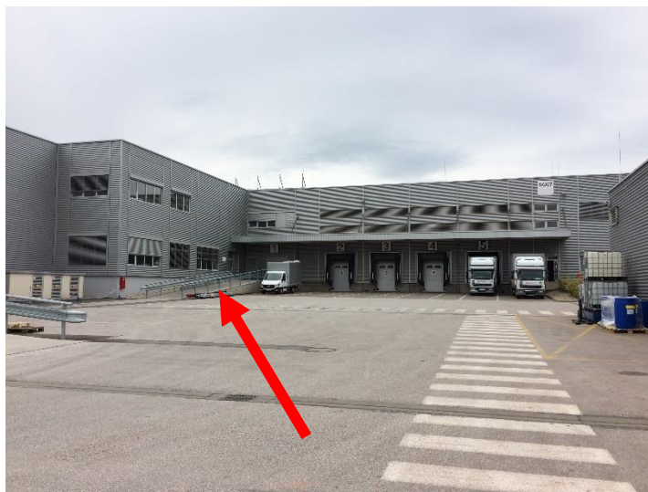
Obrázek 22 Rampa pro manipulační techniku
